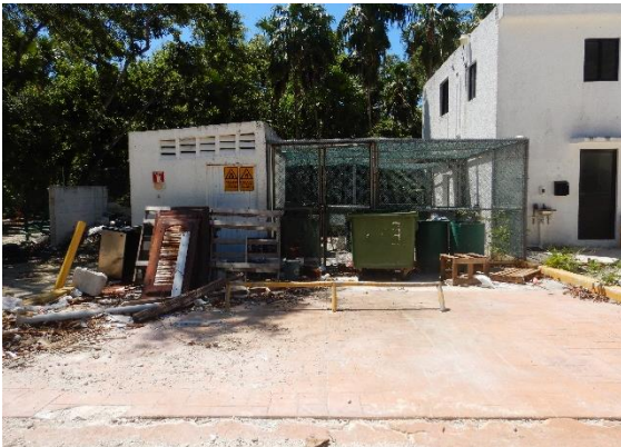
Cámaras para almacenamiento de residuos
