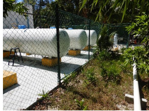
Instalación de gas LP
