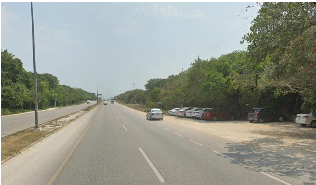
Figura 14. Carretera federal N° 307
