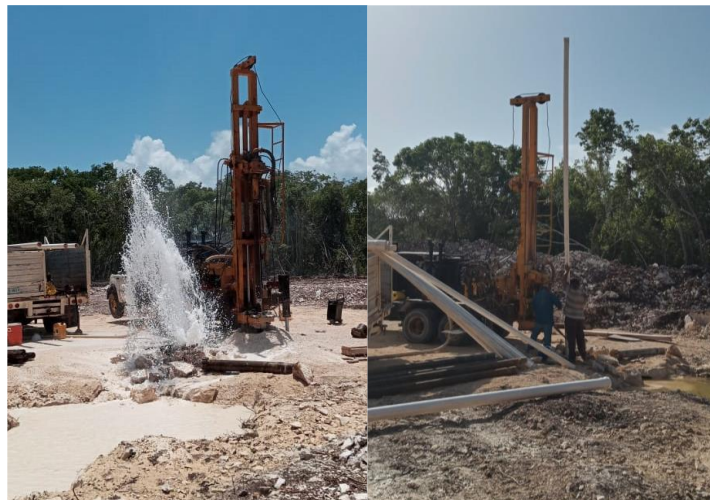
Figura 14. Vista general del equipo utilizado durante la perforación exploratoria
