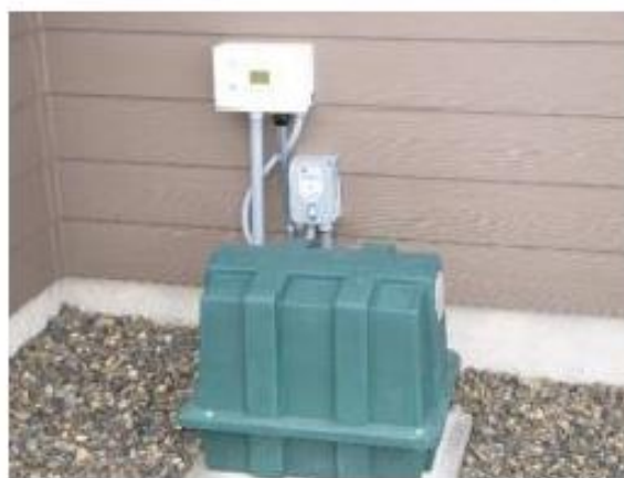
Figura 11. Imagen ilustrativa del Soplador MicroFAST con Housing
