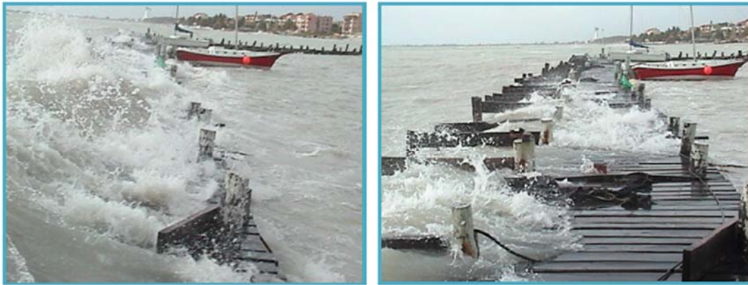
FIGURA 2.5 ROMPEOLAS EN MARINA HACIENDA DEL MAR TRAS EL PASO DEL HURACÁN IVÁN
