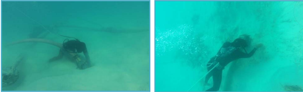
FIGURA 2.33 COLOCACIÓN DE TUBERÍAS Y MANGUERAS PARA EL TRANSPORTE DE ARENA.
