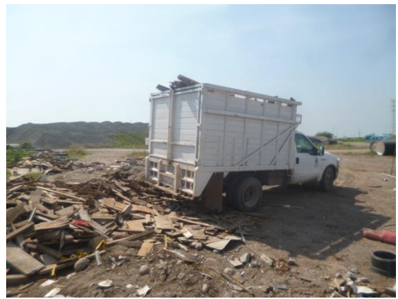
Retiro de residuos de madera de su sitio de disposición temporal.
