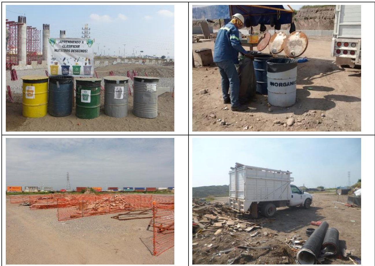
Figura II-9. Ejemplo del acondicionamiento y diferenciación y colecta de residuos sólidos urbanos y de manejo especial en proyectos en construcción.
