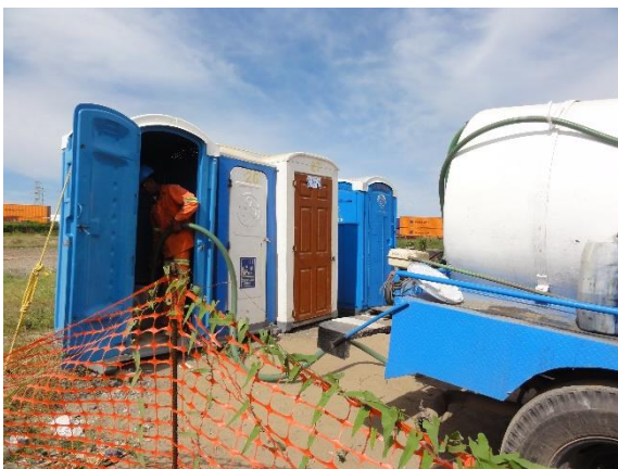
Mantenimiento de fosa séptica temporal por personal de una empresa especializada.
