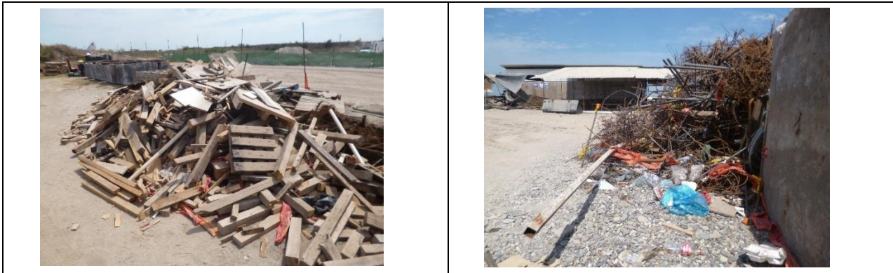
Figura II-13. Ejemplo de evidencias del mezclado durante la disposición temporal de residuos de manejo especial durante la etapa de construcción.
