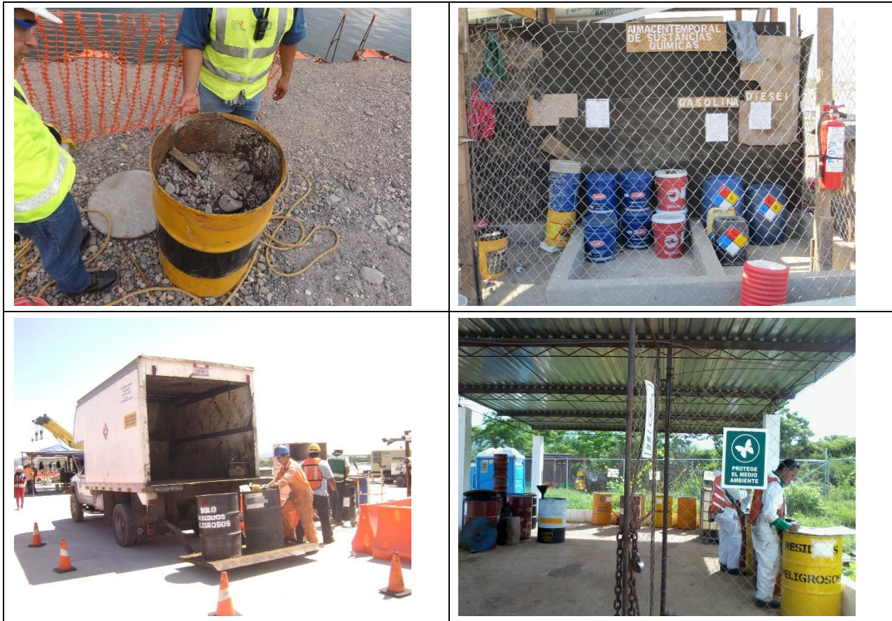
Figura II-17. Ejemplos de la prevención de la generación y manejo de los residuos peligrosos durante las etapas de preparación y construcción de proyectos de obra civil.
