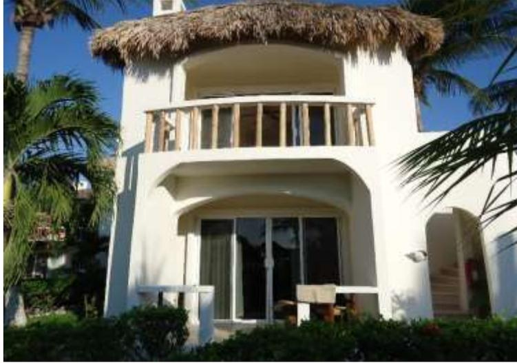
d).- Edificio 3, el cual ocupa una superficie de desplante de 44.9187 m<sup>2</sup> (cuarenta y cuatro punto nueve mil ciento ochenta y siete metros cuadrados), el cual es de dos niveles habitación 7 planta baja y habitación 8 planta alta, cimentado y construido de concreto y block con techo de concreto y la terraza del cuarto del segundo nivel es de concreto con un parteaguas hecho con zacate,
