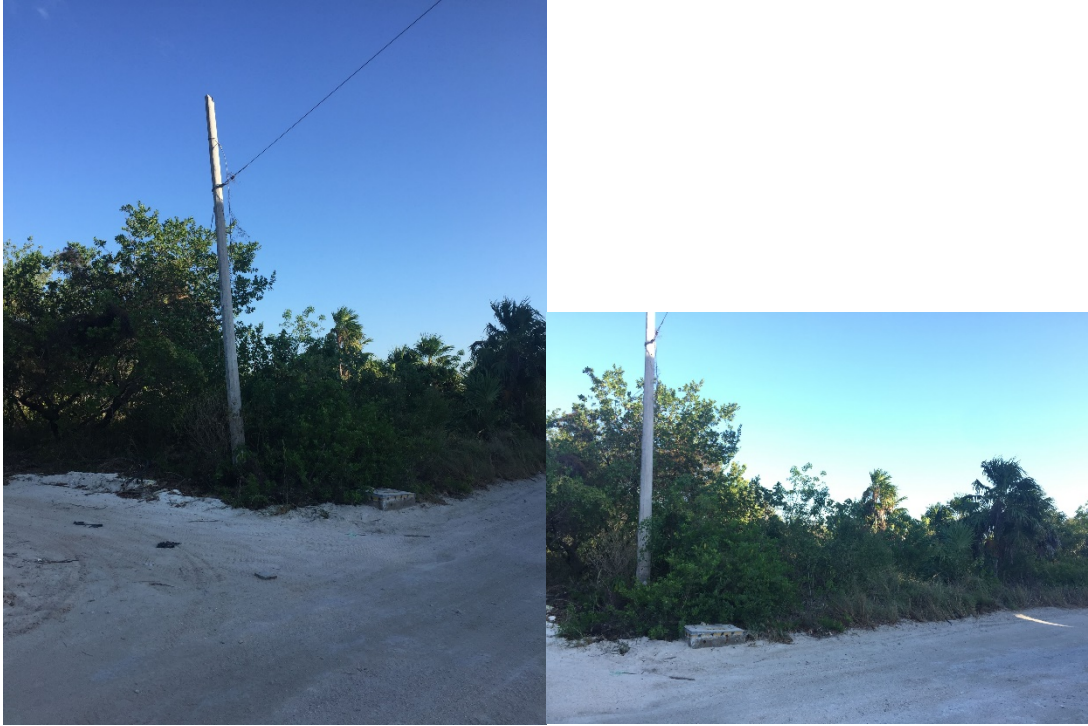
Figura 11 instalaciones de Luz y agua potable cercanas al área de proyecto
