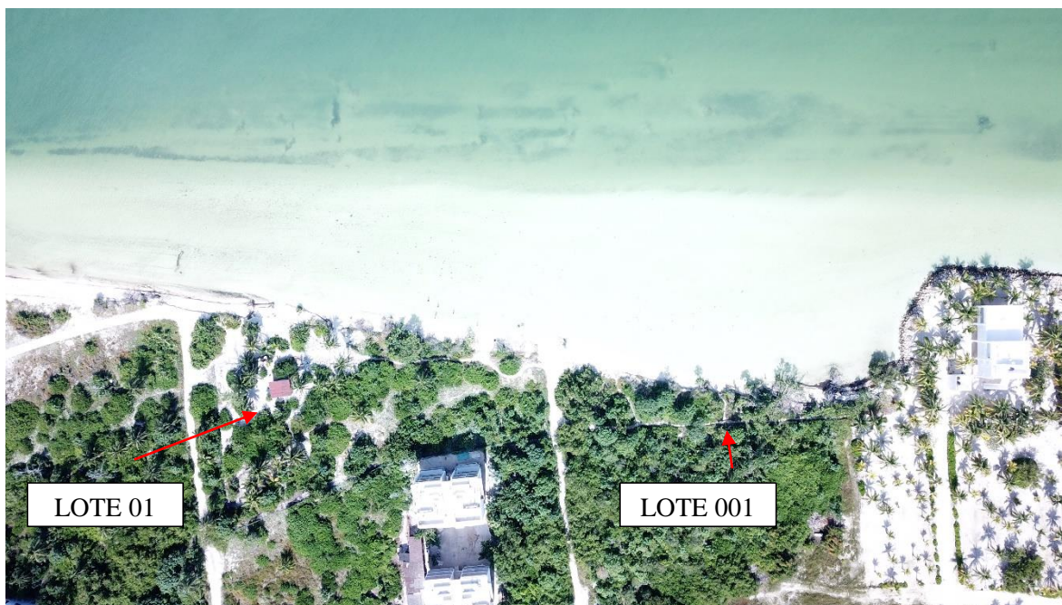
FIGURA 24. VISTA AREA DE LOS PREDIOS COMPREDIDOS PARA EL PROYECTO "DEPARTAMENTOS HOLBOX".
