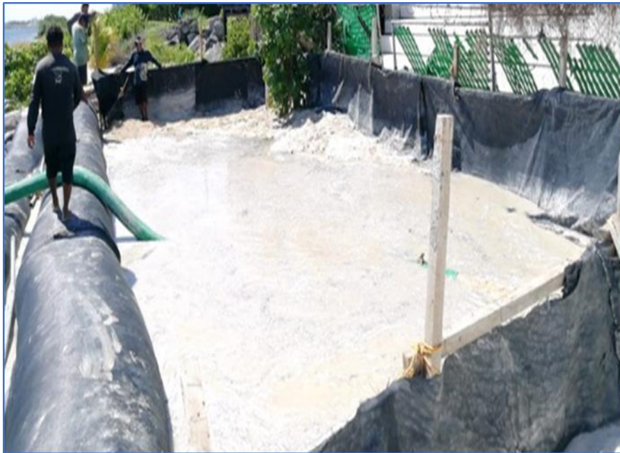
FIGURA 33. EJEMPLIFICACIÓN DE LA INSTALACIÓN DE UNA TARQUINA.
