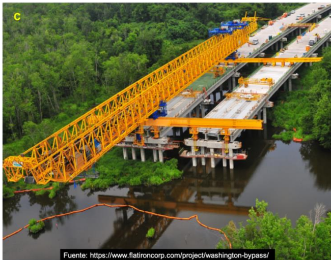
Figura 2. 45. Ejemplos de proyectos de puentes construidos por el sistema “Top Down”. Caso Proyecto Whashington Bypass, USA.
