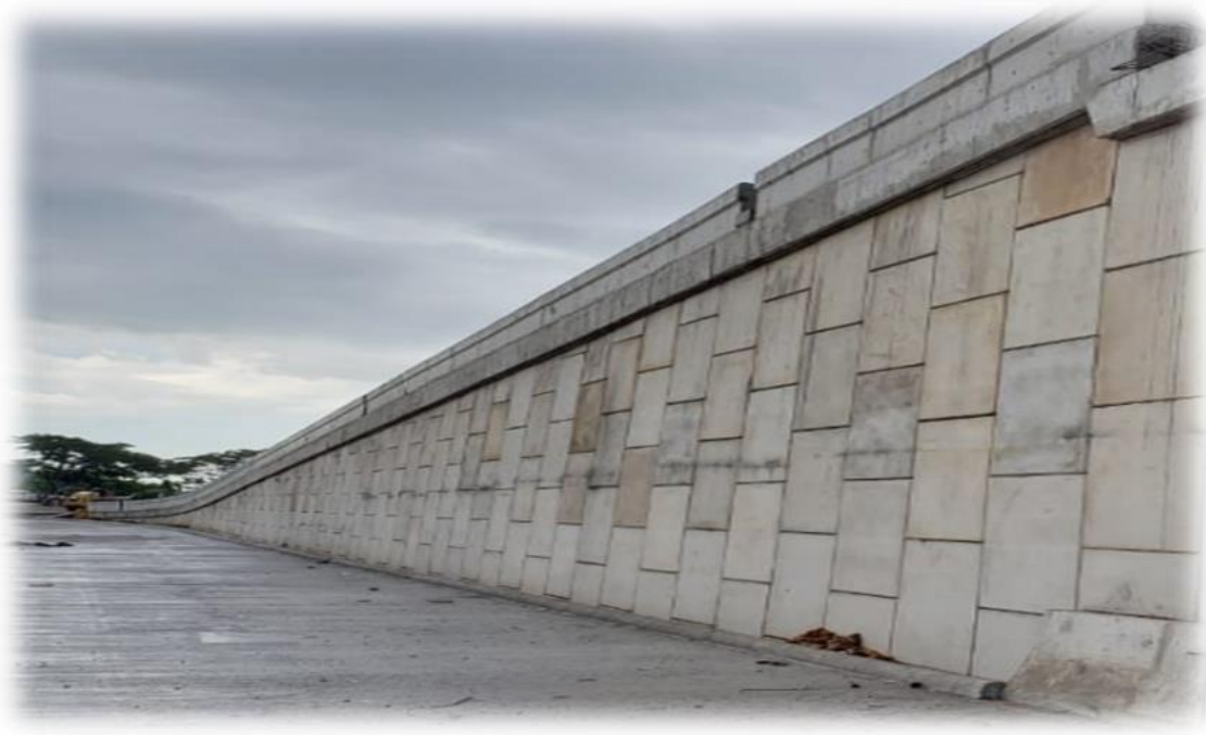
Figura 2. 51. Construcción de muro mecánicamente estabilizado terminada.
