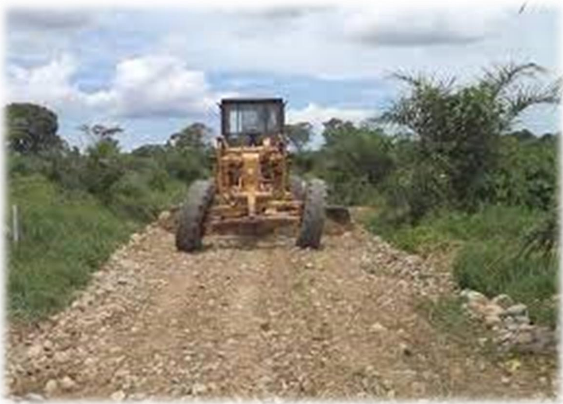
Figura 2. 52. Imagen ilustrativa de acceso con terraplén
