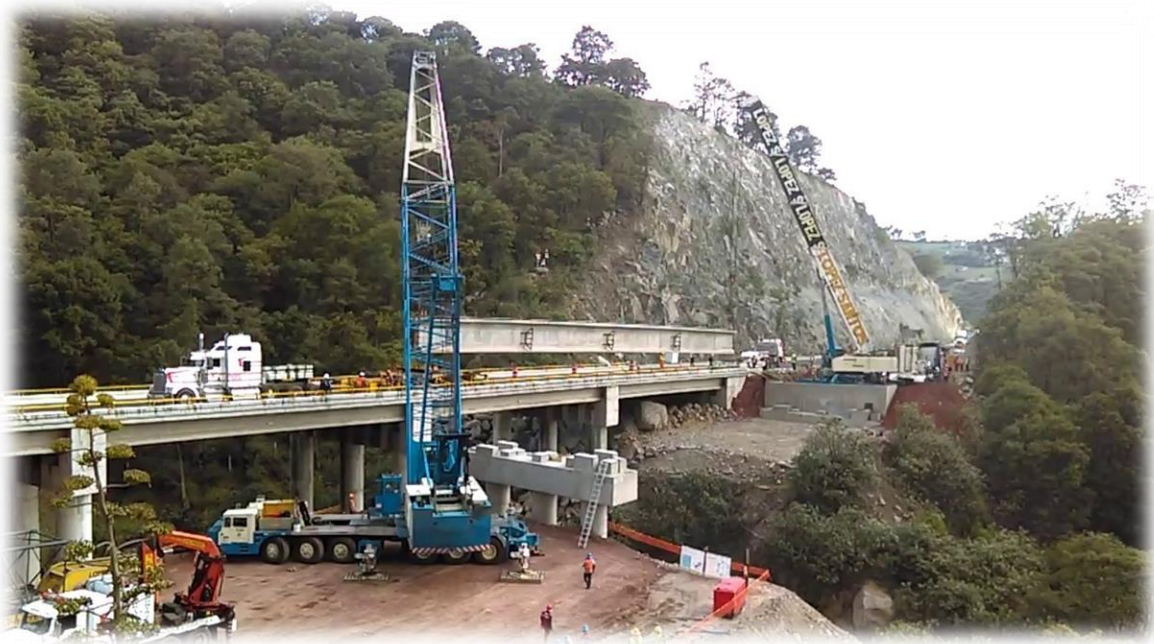
Figura 2. 57. Ejemplo de montaje de trabe
