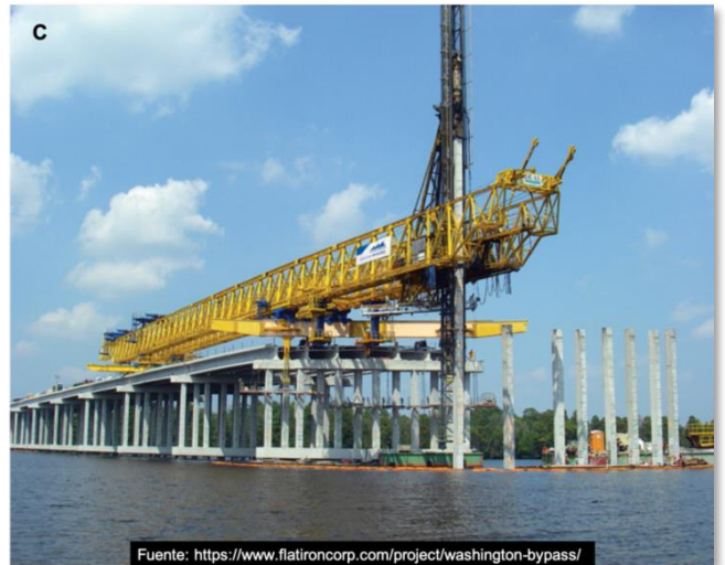
Figura 2. 45. Ejemplos de proyectos de puentes construidos por el sistema “Top Down”. Caso Proyecto Whashington Bypass, USA.
