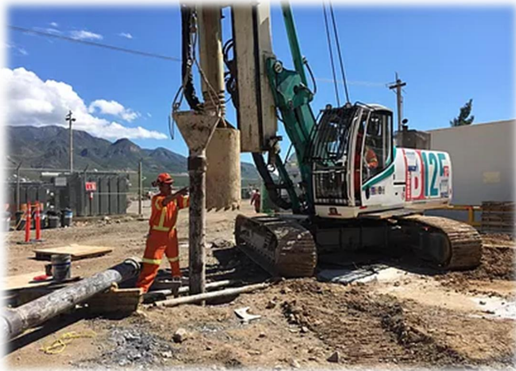
Figura 2. 56. Ejemplo de perforación de pila con la RS60
