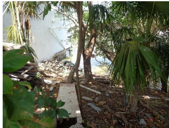
Figura 4.107. Condiciones generales de la zona este puente Nichupté, resto de material de construcción, basura en general y vegetación poco densa y seca.
