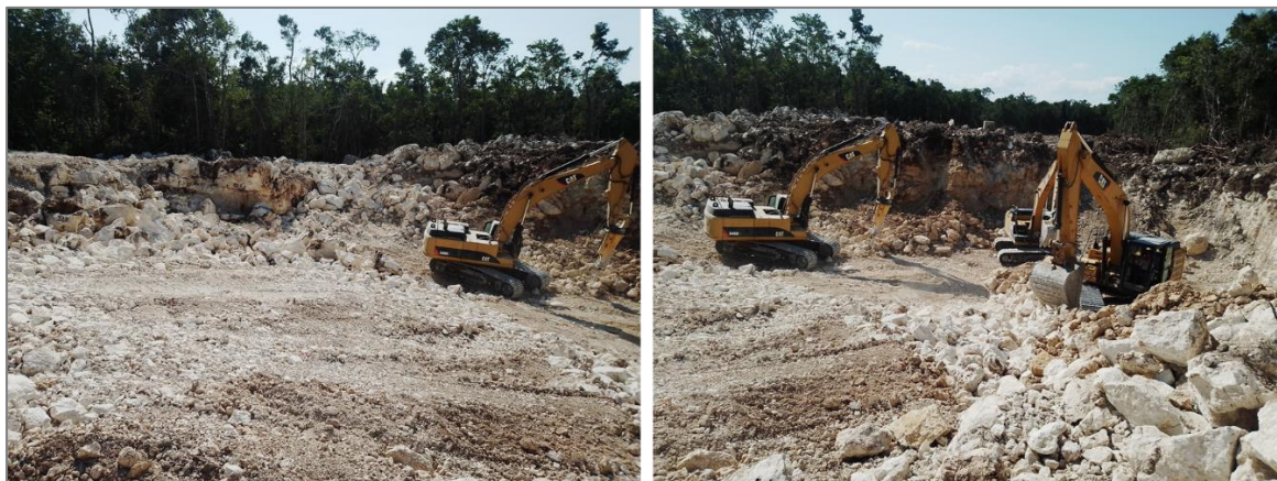
Figura IV.2.1.87. Aspectos banco de materiales sin nombre en las inmediaciones del acceso al Aeropuerto Internacional Tulum, en proceso constructivo.
