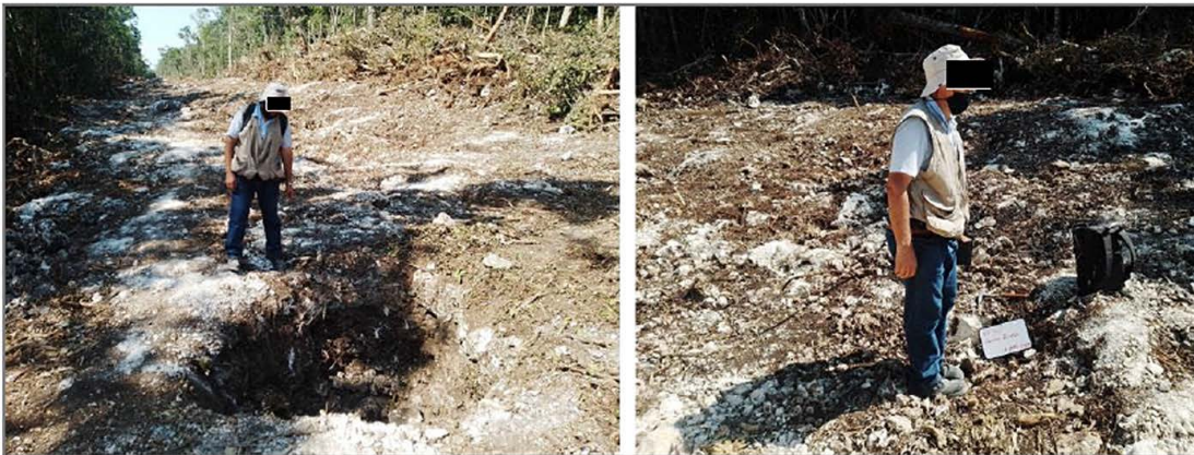
Figura IV.2.1.85. Oquedad abierta en calizas sobre el camino de acceso en proceso constructivo.
