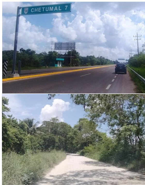
Figura IV.1.8 Vista general de las áreas desprovistas de vegetación
