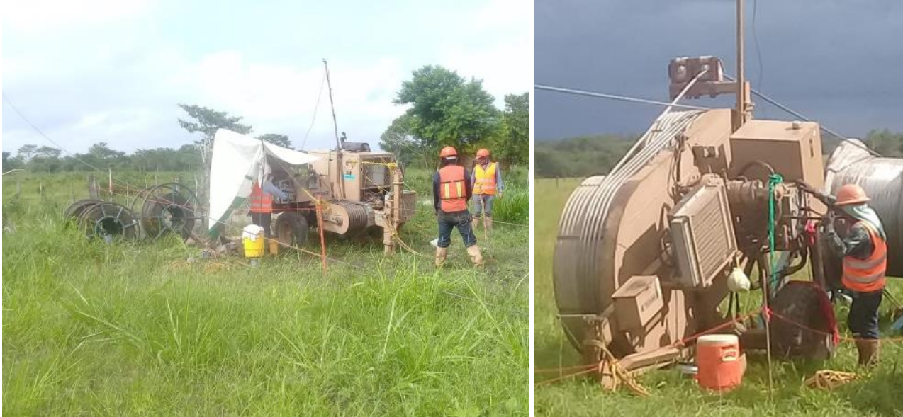
Figura 12. Traccionadora para el tendido del cable (Izq.) y Devanadora (Der.)
