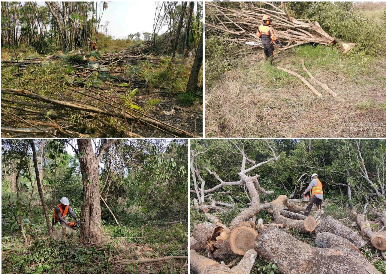
Figura 5. Imágenes ilustrativas del desmante con derribo direccional.
