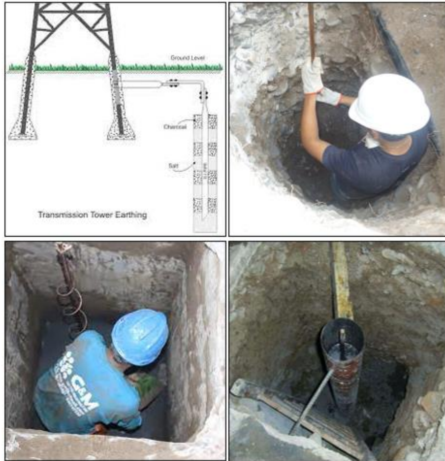
Figura 13. Imagen ilustrativa de la instalación del sistema de tierras.
