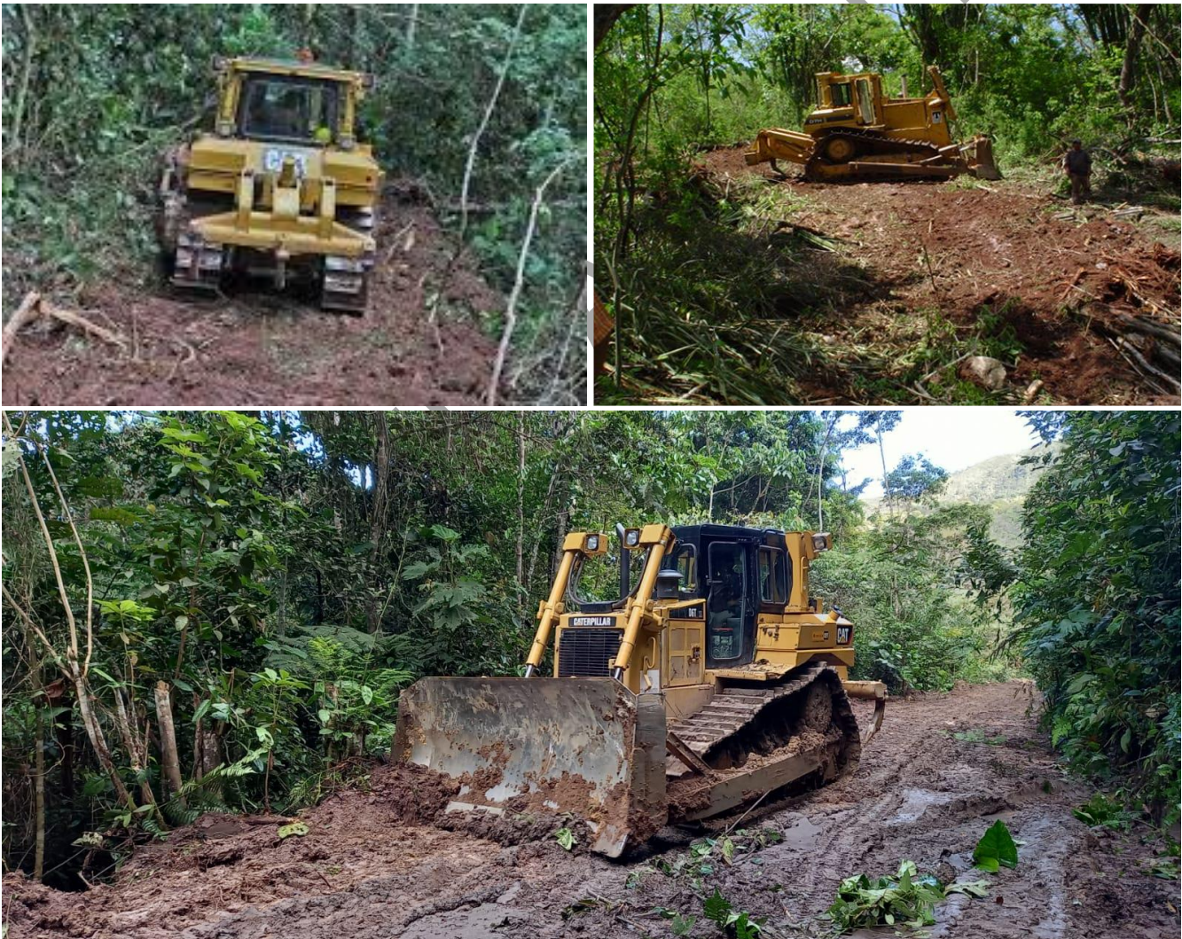
Figura 6. Imágenes ilustrativas del despalme durante la etapa preparación del sitio.
