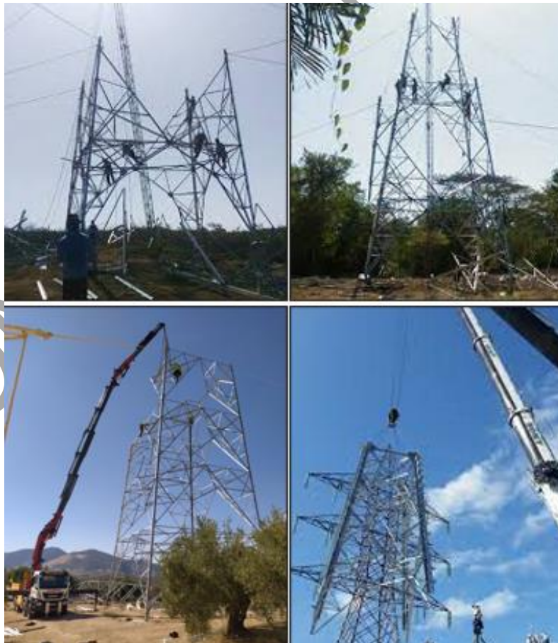
Figura 8. Montaje de estructuras.
