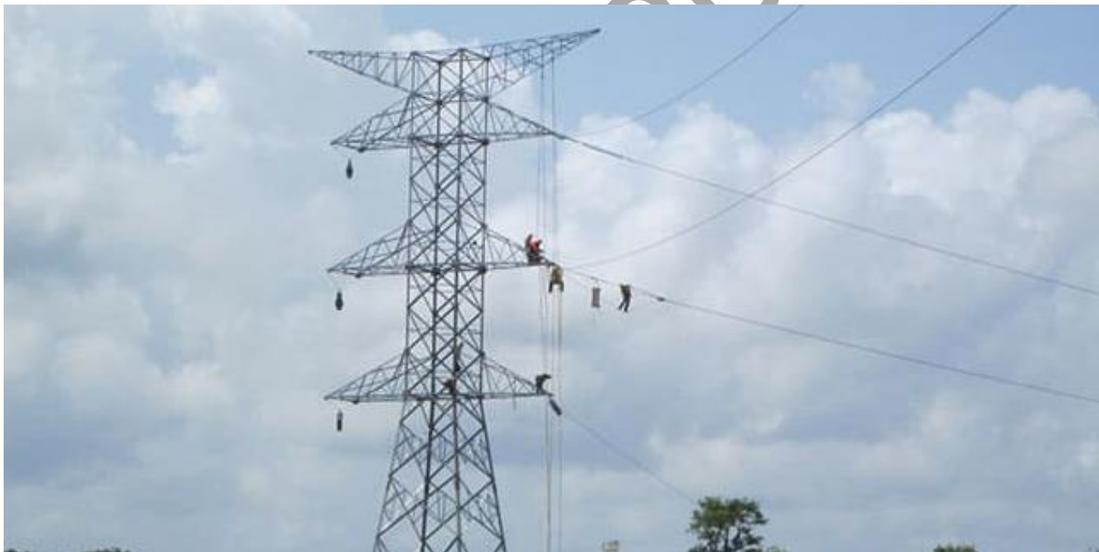
Figura 11. Maniobras sobre una torre autoportada para el tendido y tensado de cable conductor.
