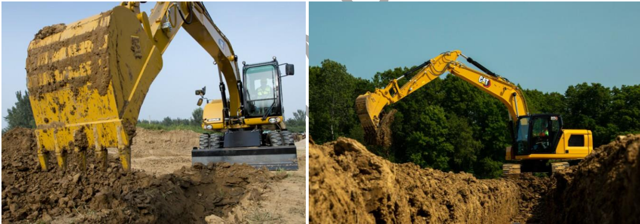
Figura 7. Imágenes ilustrativas de la excavación a cielo abierto durante la etapa de construcción (Obra civil).
