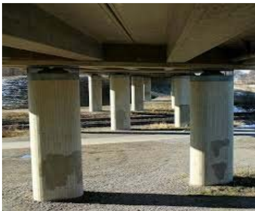
FIGURA 2.14 ESTRUCTURAS MUELLE EN FORMA DE T
