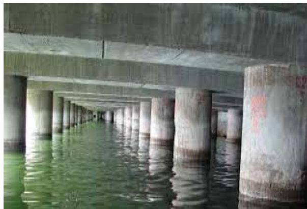
FIGURA 2.14 ESTRUCTURAS MUELLE EN FORMA DE T
