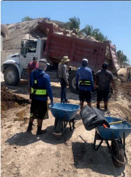
FIGURA 2.15 CAMINO POR EL QUE SE TRANSPORTÓ LA ROCA DE CALCIO AL SITIO DE ACOPIO PARA SU POSTERIOR COLOCACIÓN, Y EL TRANSPORTE DE LA ROCA HACÍA EL SITIO DESIGNADO PARA SU ACOPIO TEMPORAL
