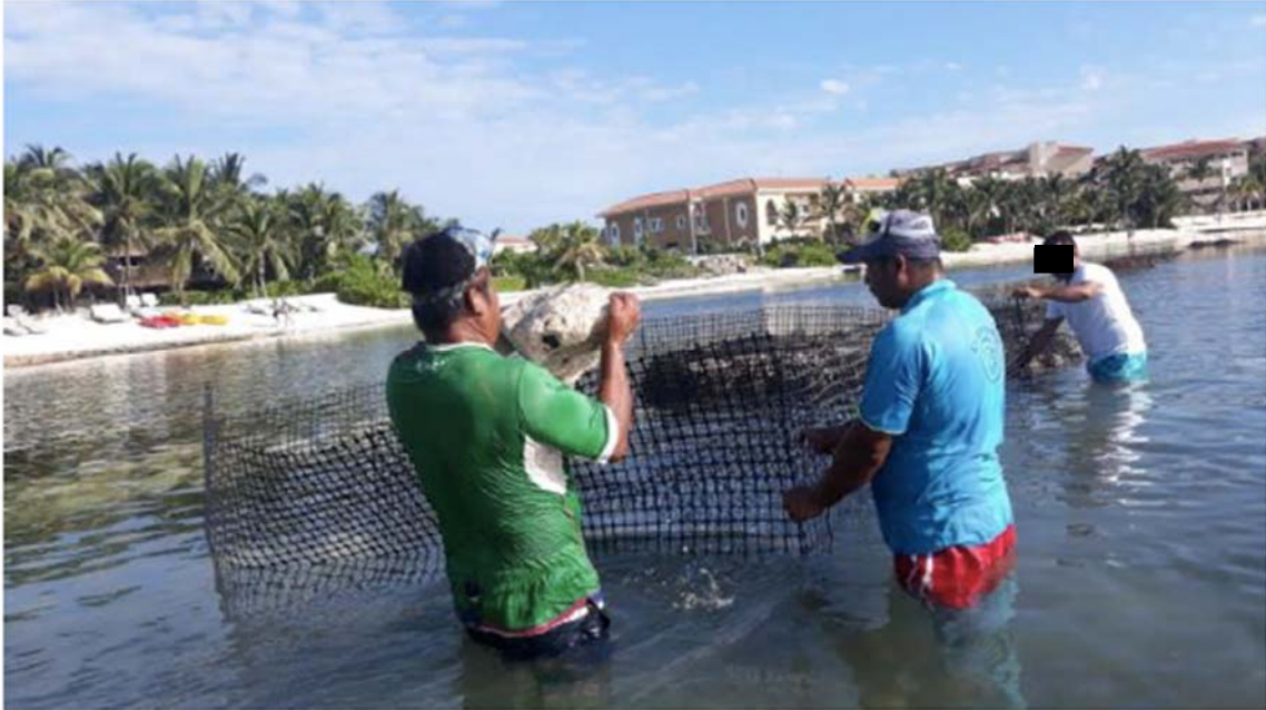
FIGURA 2.18 EJEMPLO DE COLOCACIÓN DE ROCAS PARA LA FORMACIÓN DE GAVIONES MARINOS OCEANUS
