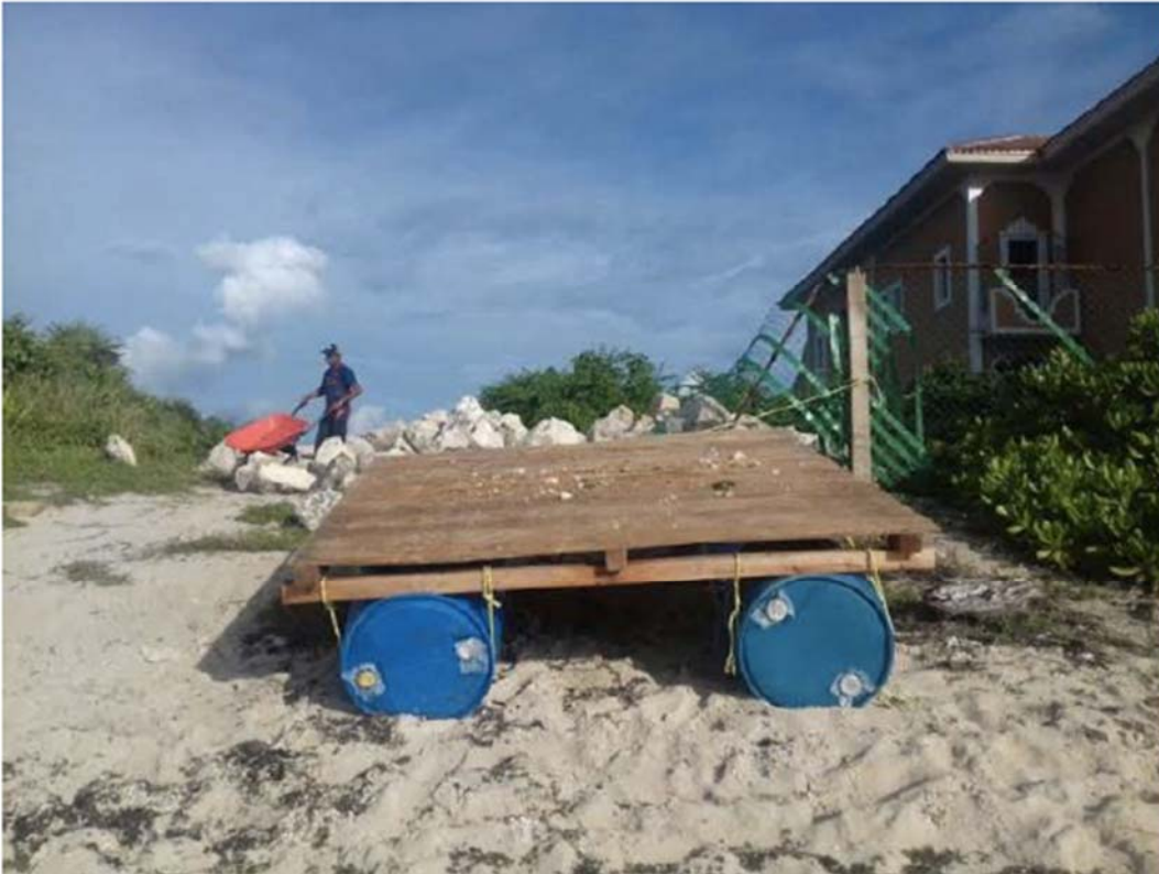
FIGURA 2.17 CHALANA PREFABRICADA PARA EL INGRESO DE ROCA AL MAR
