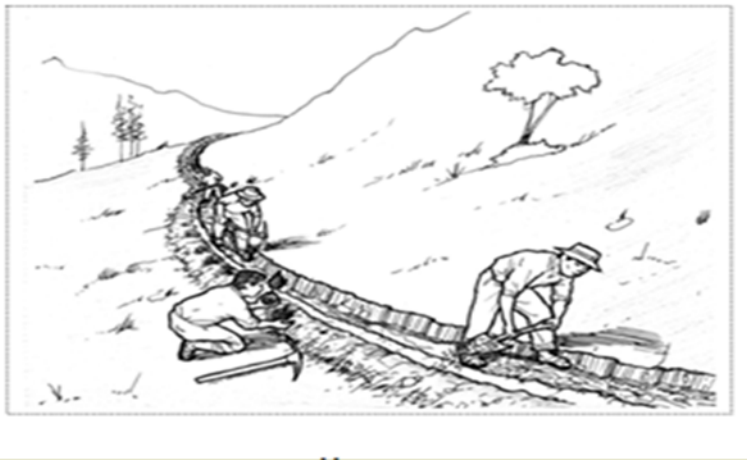
FIGURA 6.1 EJEMPLO DE OBRA DE CONSERVACIÓN DE SUELO
