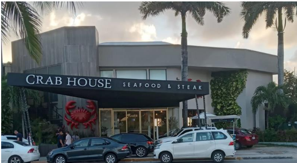
Foto 3.- Vista desde el Boulevard Kukulkán de las instalaciones del área 3
