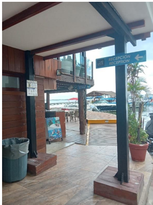
Foto 13.- Contenedor de residuos a la vista del público en la recepción de la Marina.
