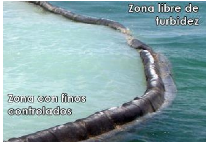
Figura 6. Se muestra a manera de ejemplo el funcionamiento de la malla antidispersión.
