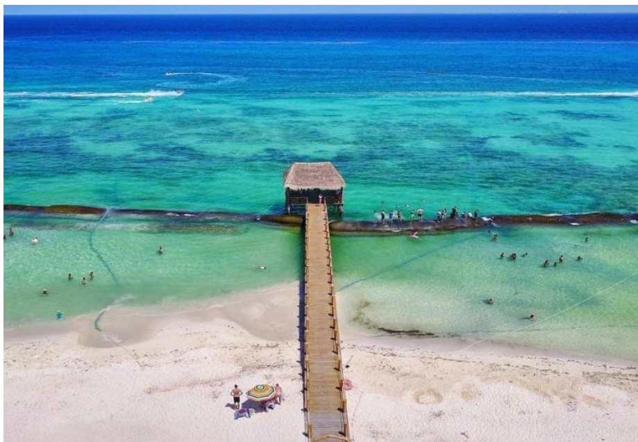
Muelle y estructuras de protección costera en playa Xcalacoco.
