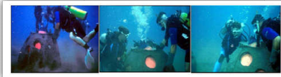
Colocación de estructuras utilizando la técnica de descenso controlado.
