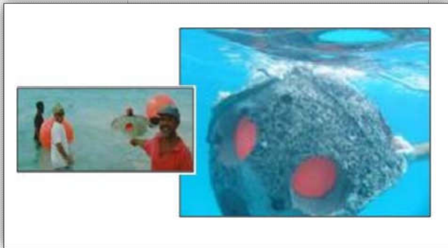
Colocación de un fuerte globo de Polyform dentro de la oquedad.
