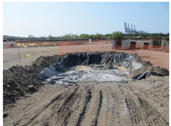
Habilitado de área para la disposición temporal de residuos de mezcla.
