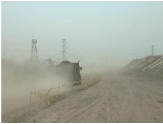
Suspensión de partículas de polvo en un camino de terracería por donde se transporta material de construcción.
