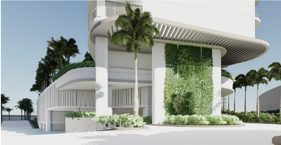
Acceso al sótano S de Torre Isla
