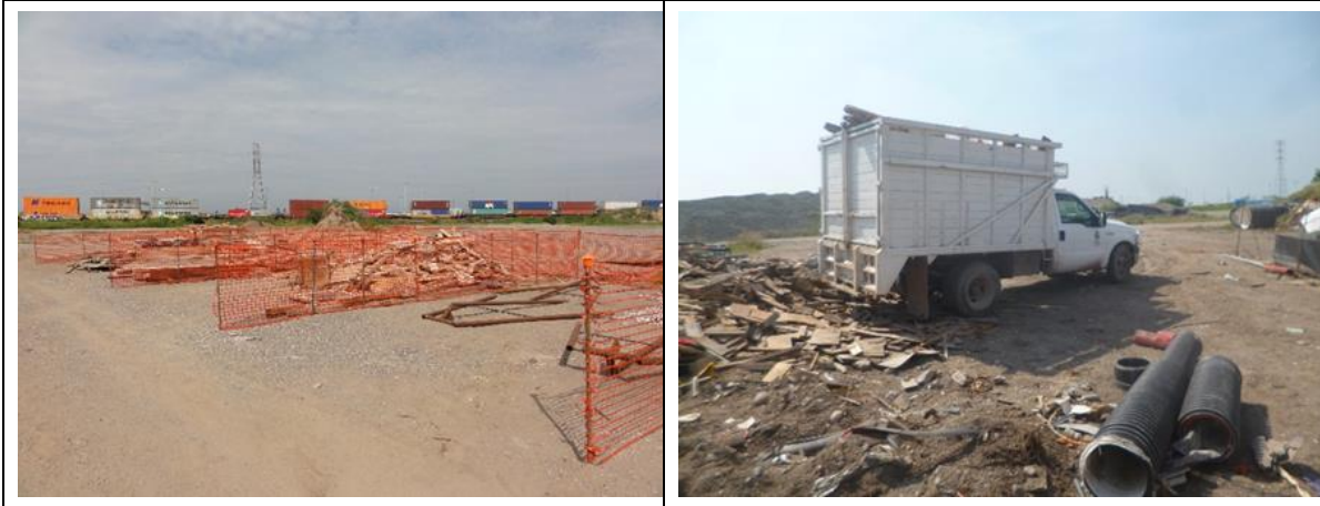
Figura II-13. Ejemplo del acondicionamiento y diferenciación y colecta de residuos sólidos urbanos y de manejo especial en proyectos en construcción.
