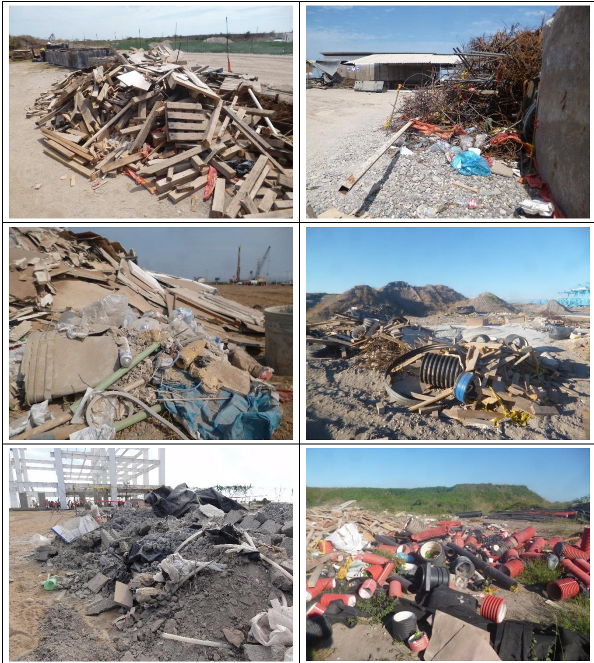
Figura II-16. Ejemplo de evidencias del mezclado durante la disposición temporal de residuos de manejo especial durante la etapa de construcción.
