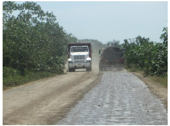
Aplicación de riegos para reducir la suspensión de partículas de polvo en el aire en los frentes de trabajo y circulación vehicular.
