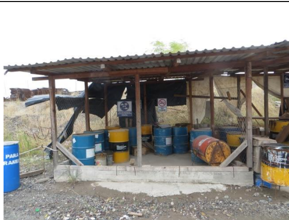
Habilitado de un almacén para la concentración momentánea de residuos peligrosos y sustancias químicas en un frente de trabajo.
