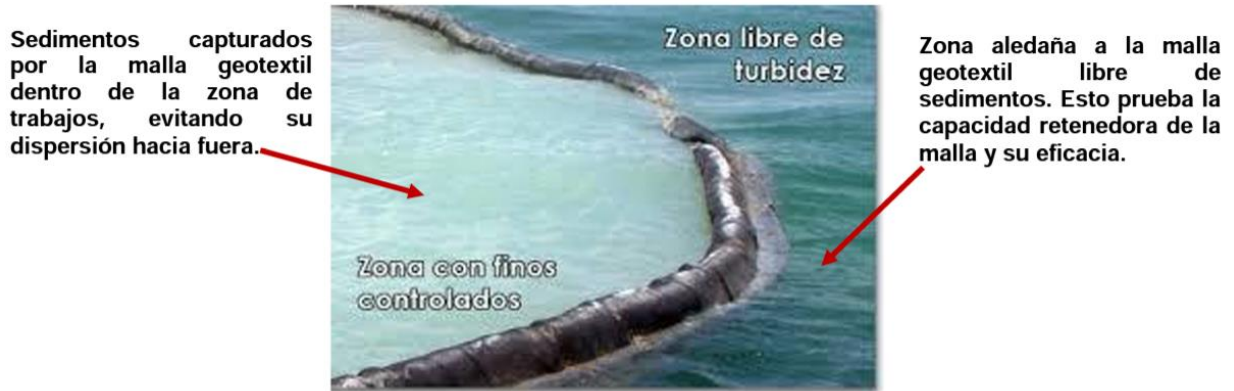
Figura 9. En la imagen de arriba, se observa una ejemplificación de la forma correcta de colocar la malla geotextil perimetral, para evitar la dispersión de sedimentos, boyas flotantes en la parte de arriba y plomos en la parte inferior. En la imagen de abajo se observa una malla ya colocada, se aprecia con claridad el efecto mitigador de la malla para evitar la dispersión de sedimentos.
