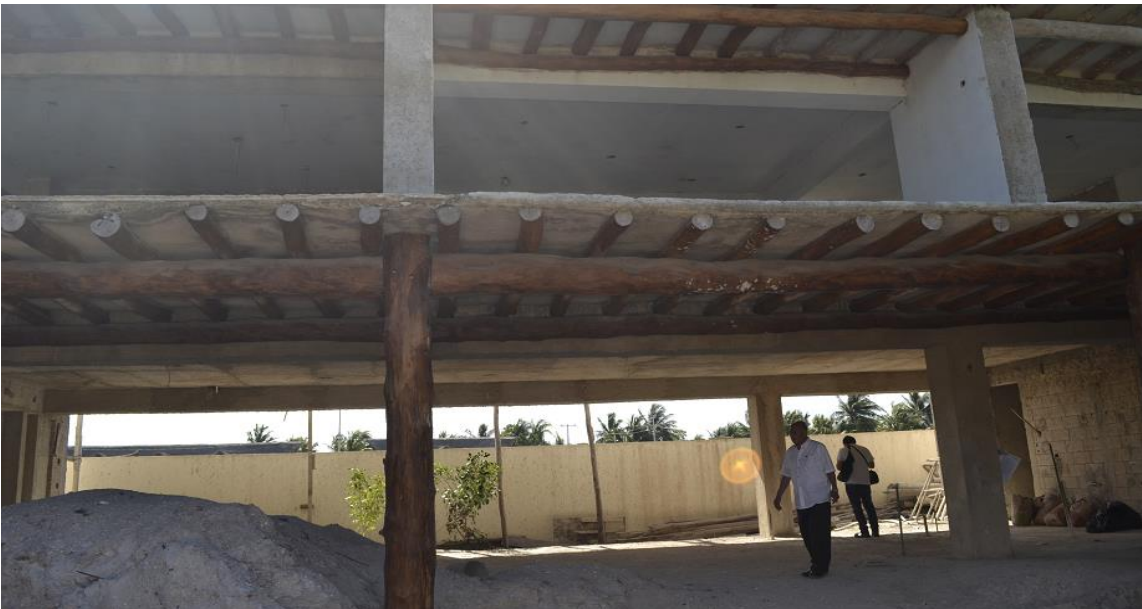
Figura II_ 10. Panorámica del Módulo I de la Posada Casa Montiel.
