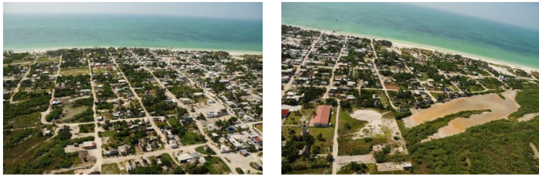
Figura IV_ 13. Panorámicas del centro de población de Holbox.
