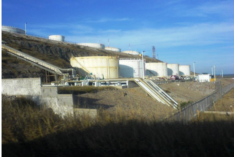
Figura IV.91. Tanques elevados PEMEX.
