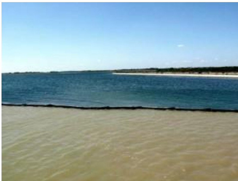
Figura II.31. Ejemplo de la operación de una barrera antiturbidez.
