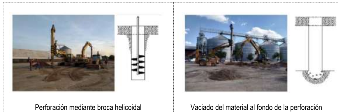
Figura 6. Construcción de las columnas de grava
