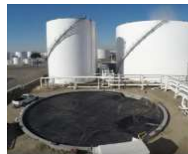
Colocación de geotextil para evitar filtraciones al subsuelo
