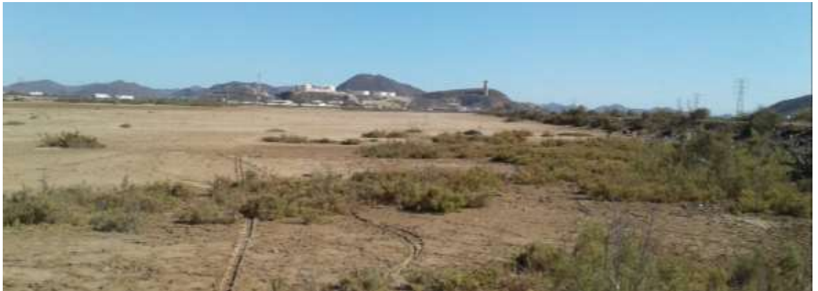
Figura 8. En esta porción del sitio RAMSAR se localiza la Central termoeléctrica Ing. Juan de Dios Bátiz Paredes que se observa, así como instalaciones de PEMEX, ductos y líneas eléctricas
