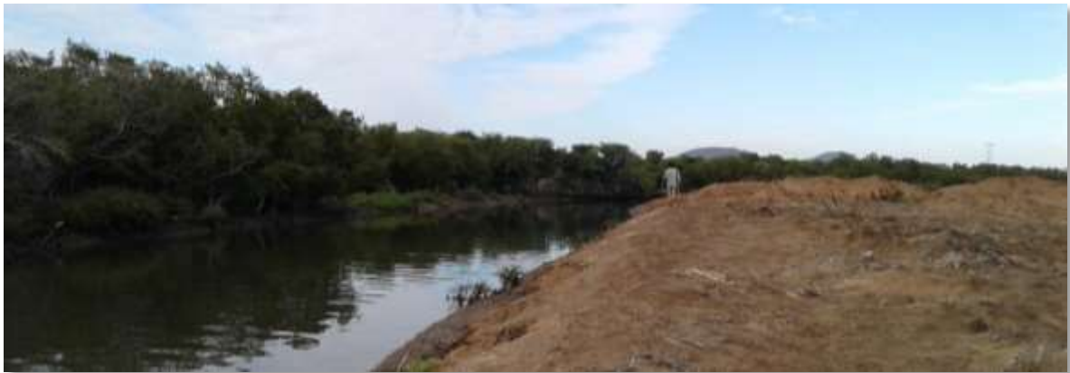
Figura 13. Vista del canal de descarga de la planta de tratamiento de Los Mochis a la Bahía de Ohuira
