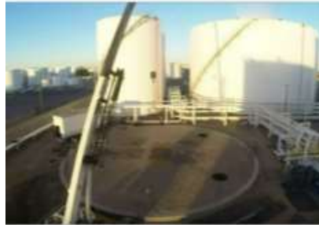
Colocación de arena e inicio de colocación de la estructura del tanque
