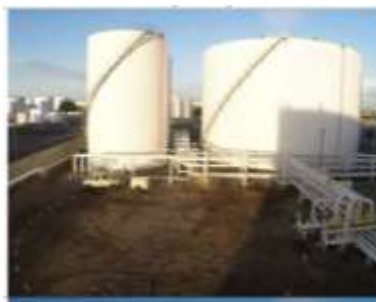
Trazo y nivelación del tanque sobre la plataforma
