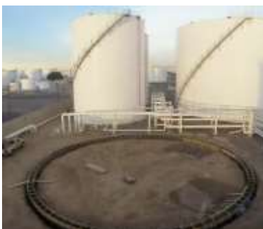
Cimbrado del anillo de concreto
