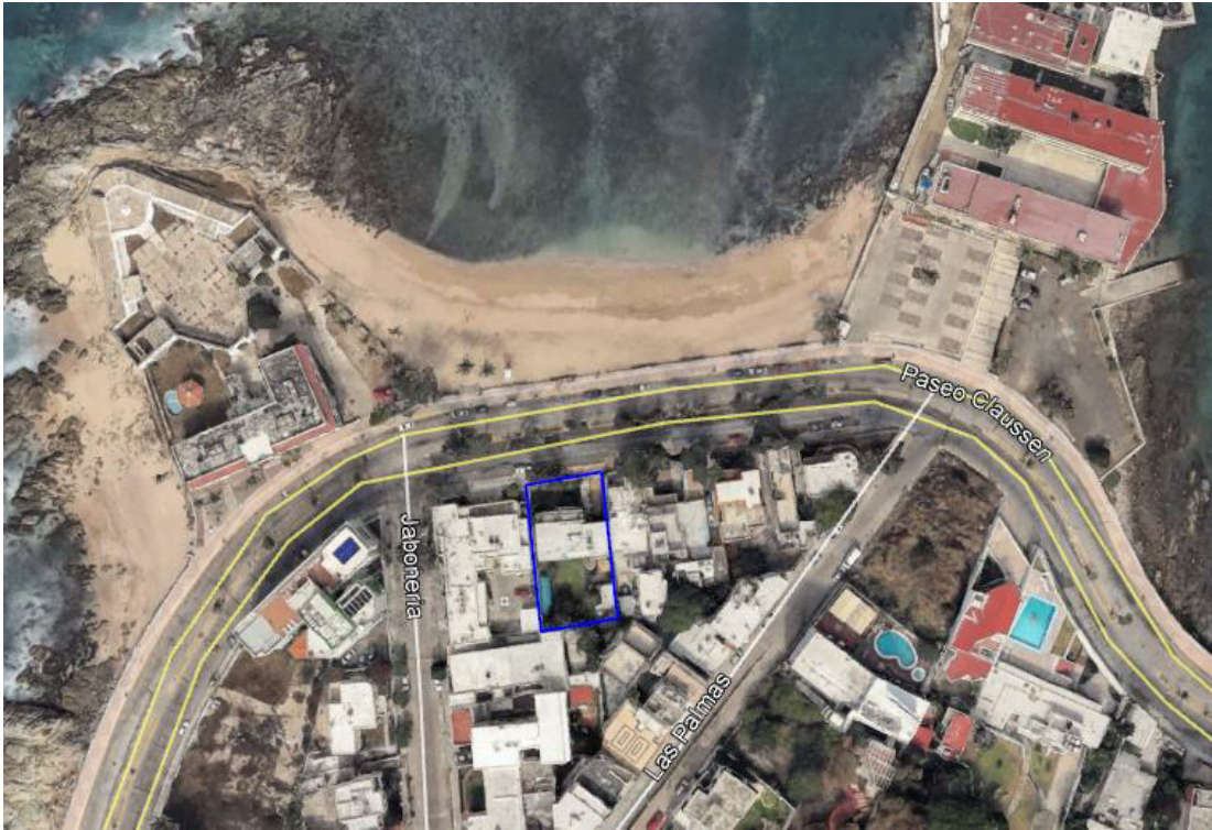
FIGURA 1. UBI CACIÓN DEPARTAMENTOS “EDIFICIO 13” (google Earth).
