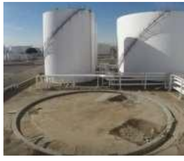
Colado de anillo de concreto, el espacio perimetral de la zanja se rellena con arena compactada al 95%
