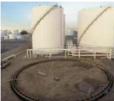
Cimbrado del anillo de concreto
