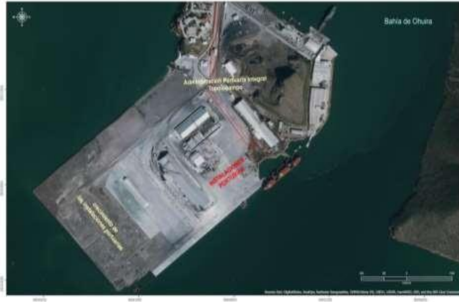
Figura 4. Vista aérea del muelle Triple T donde se construirán las instalaciones portuarias
