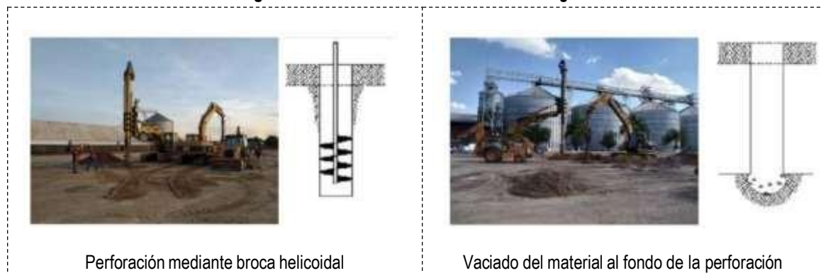
Figura 6. Construcción de las columnas de grava
