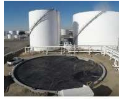
Colocación de geotextil para evitar filtraciones al subsuelo
