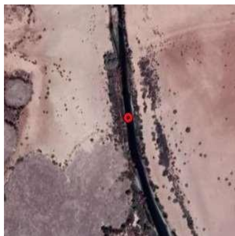
Canal de riego X=696838, Y=2838807
