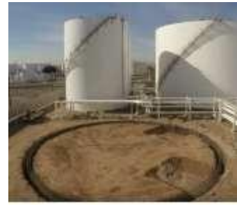
Colocación del acero de refuerzo
