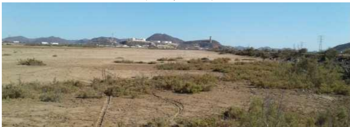
Figura 8. En esta porción del sitio RAMSAR se localiza la Central termoeléctrica Ing. Juan de Dios Bádiz Paredes que se observa, así como instalaciones de PEMEX, ductos y líneas eléctricas
