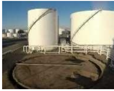
Excavación de la zanja para el anillo circular de concreto
