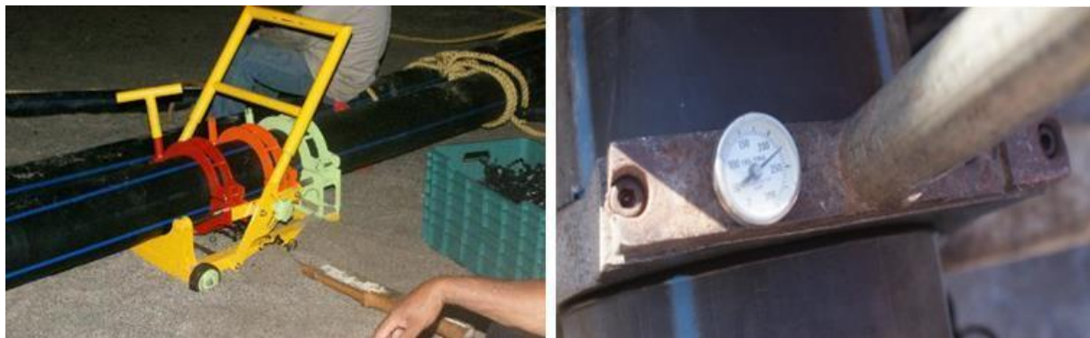
Figura II.11. Termofusión del tubo de flotación exterior para el cierre del círculo.
