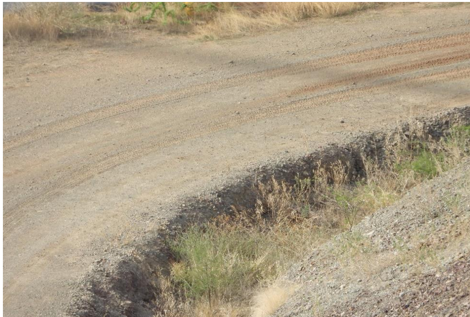
Fotografía II.1. Ejemplo de camino de acarreo
