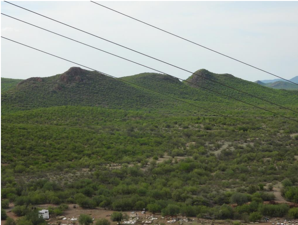
Fotografía II.6. Ejemplo de líneas eléctricas en el área del proyecto
