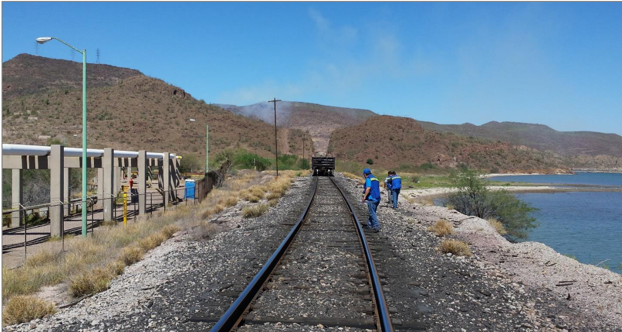
Figura 31. Panorámica de vías férreas ingresando a las instalaciones de recinto portuario a través de corte en el cerro aledaño a PEMEX, en el área de expansión del Puerto de Guaymas, Sonora.
