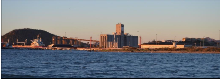
Figura 165. Fotografía de la estación de muestreo EMP-01 en la costa oeste de la Laguna de Empalme para el proyecto de expansión del Puerto de Guaymas, Sonora.
