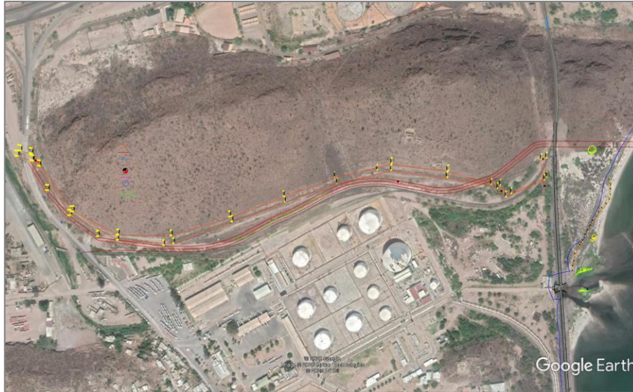
Figura 33. Imagen de satélite que muestra el levantamiento en campo del derecho de vía del poliducto de PEMEX sobre la ladera del cerro ubicado al norte de la planta de almacenamiento y distribución de esa empresa. Se puede apreciar también el posible trazo del camino de acceso propuesto para la expansión del Puerto de Guaymas, Sonora.
