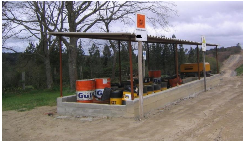
Almacén temporal de residuos peligrosos
