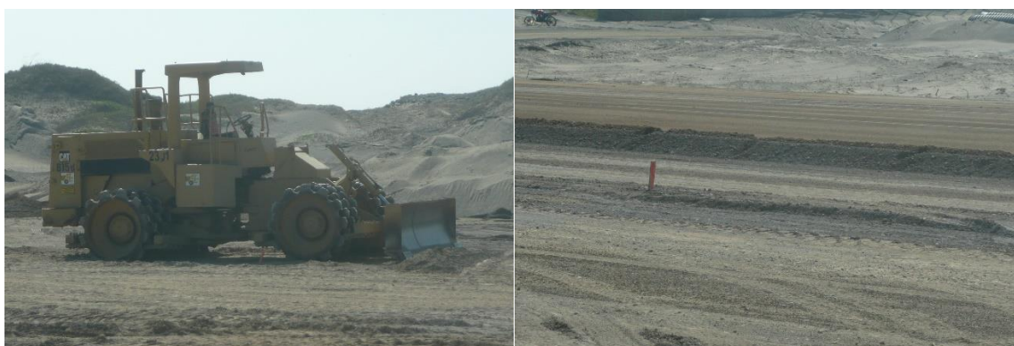
Vibrocompactador pata de cabra para conformación de terraplenes
