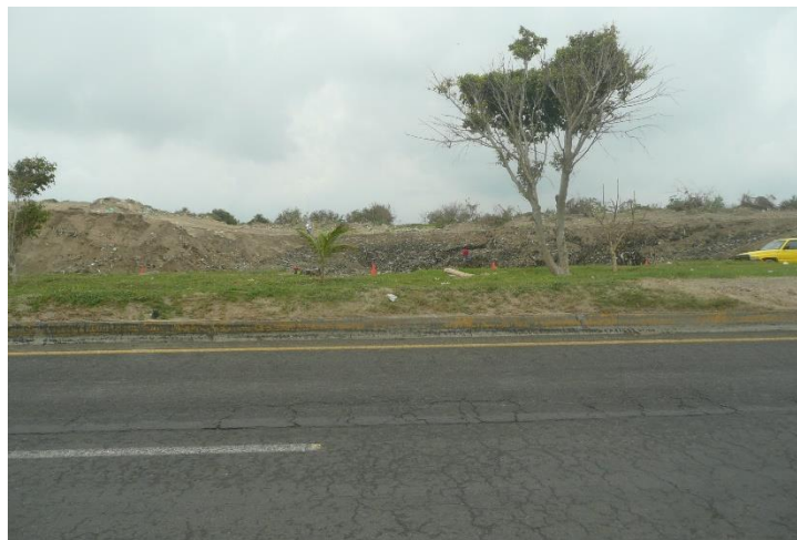
Entronque del camino de acceso a contratistas con el Boulevard 13.5
