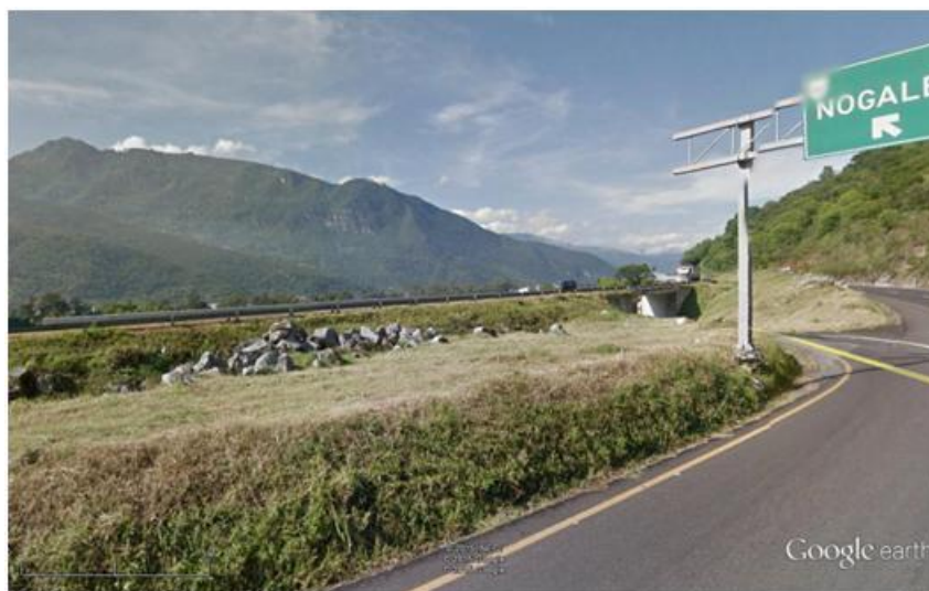
Figura II.58. Vista panorámica del PSV en el Entronque nogales Cad. 252+300, al fondo se observa el paso.
