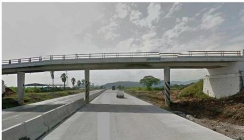
Foto II. 2. Aspecto actual de la autopista 160 D en el kilómetro 295+550, en las inmediaciones del entronque con el Periférico, sitio de conclusión del Proyecto. Vista hacia el sureste, dirección a Veracruz.
