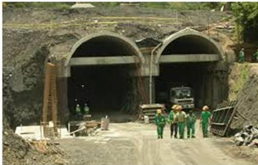
Foto II. 14. Foto ilustrativa de un falso túnel en construcción, se observa la estructura de concreto armado que conforma el cuerpo resistente del túnel.
