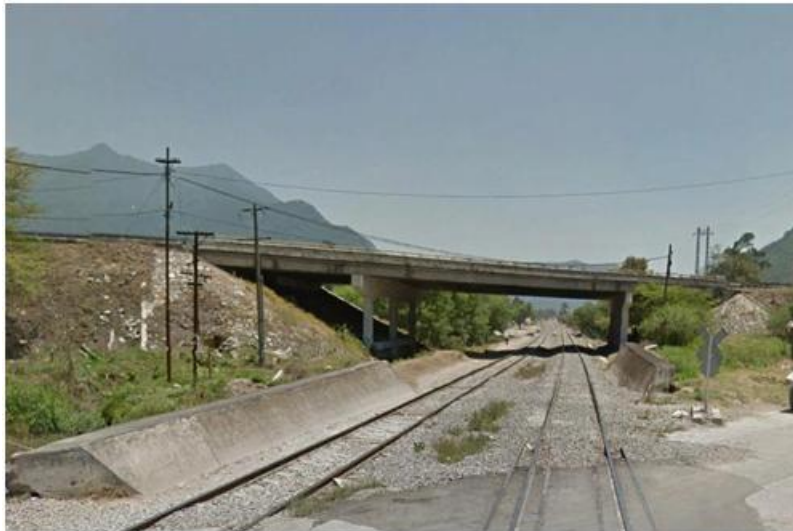
Foto Il. 21. Vista con dirección hacia Veracruz, se observa la estructura del puente a base de concreto reforzado, el puente se ampliará para alojar los carriles laterales.
