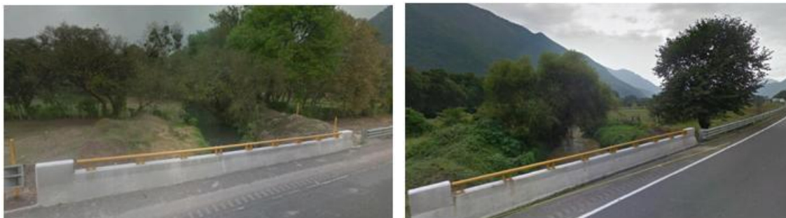
Foto II. 9. Puente en el kilómetro 255+100, vistas hacia aguas abajo y aguas arriba respectivamente, se observan las estructuras de barandales en excelente estado.
