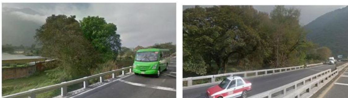
Foto II. 9. Puente en el kilómetro 255+100, vistas hacia aguas abajo y aguas arriba respectivamente, se observan las estructuras de barandales en excelente estado.
