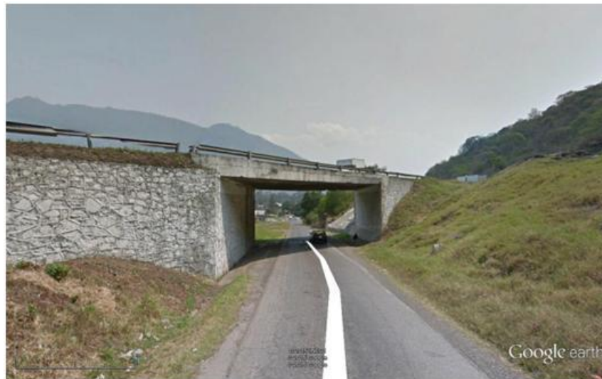
Figura II.59. Vista en detalle del PSV Entronque Nogales Cad. 252+300. Se observa la estructura con muros de mampostería y losa de concreto armado. Este paso se ampliará, probablemente con traveses prefabricados para el alojamiento de los carriles laterales del Periférico
