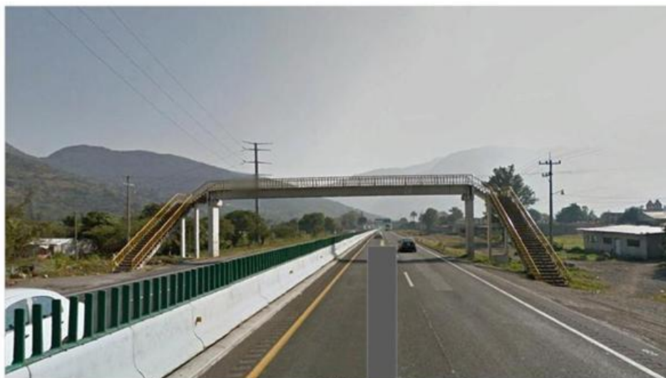
Foto II. 17. Vista actual del paso peatonal en las inmediaciones de la colonia El Encinar, cerca de las instalaciones de PEMEX. El puente se prolongará hacia la izquierda y derecha para pasar sobre los carriles laterales que se construirán
