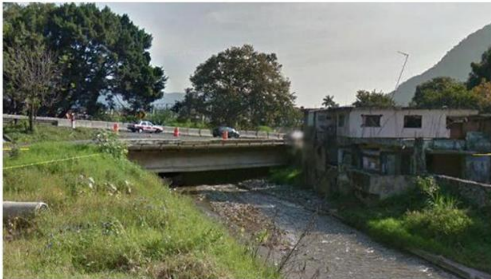
Foto II. 6. Fotografía del aspecto actual del puente, desde la calle Nicolás Bravo de la colonia Nogales, en la que se puede ver parte de la actual estructura del puente integrada con traveses prefabricados de concreto armado.
