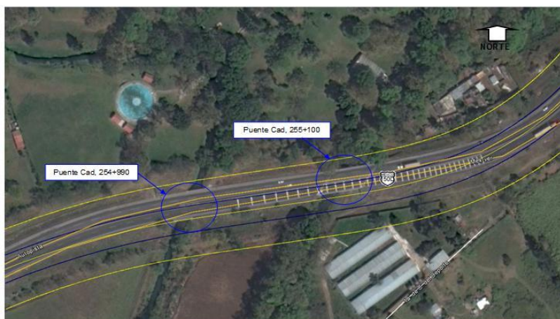
Figura II.24. Toma aérea del sitio de ubicación de los puentes sobre los brazos del Río Blanco en las inmediaciones de la colonia Chapultepec, se observa el trazo aproximado del derecho de vía de la Autopista en proyecto.
