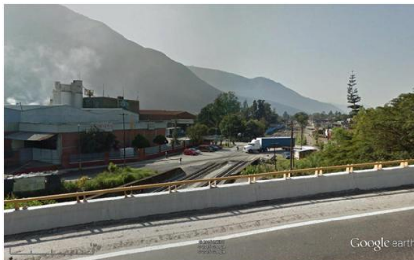
Foto II. 20. Vista desde la parte superior del puente en dirección a Ciudad Mendoza, se observa que el puente termina en el acotamiento y será necesario construir la estructura que dé cabida a los carriles laterales del nuevo proyecto.
