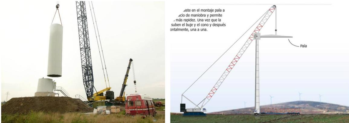
**Figura 2.11.** Montaje de la torre y palas que componen a un aerogenerador.
