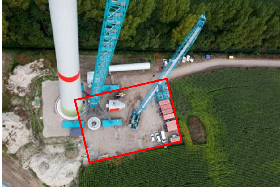
Figura 2.14. El cuadro rojo muestra un ejemplo de la plataforma de trabajo, donde se observa las grúas que levantan los componentes de los aerogeneradores.
