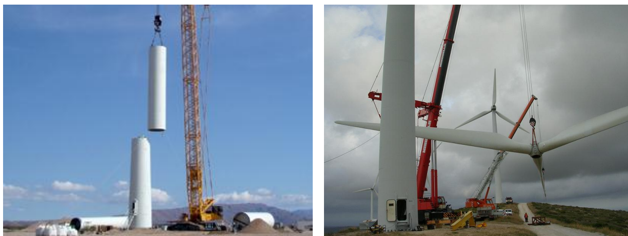
Figura 2.10. Montaje de la torre y palas que componen a un aerogenerador.
