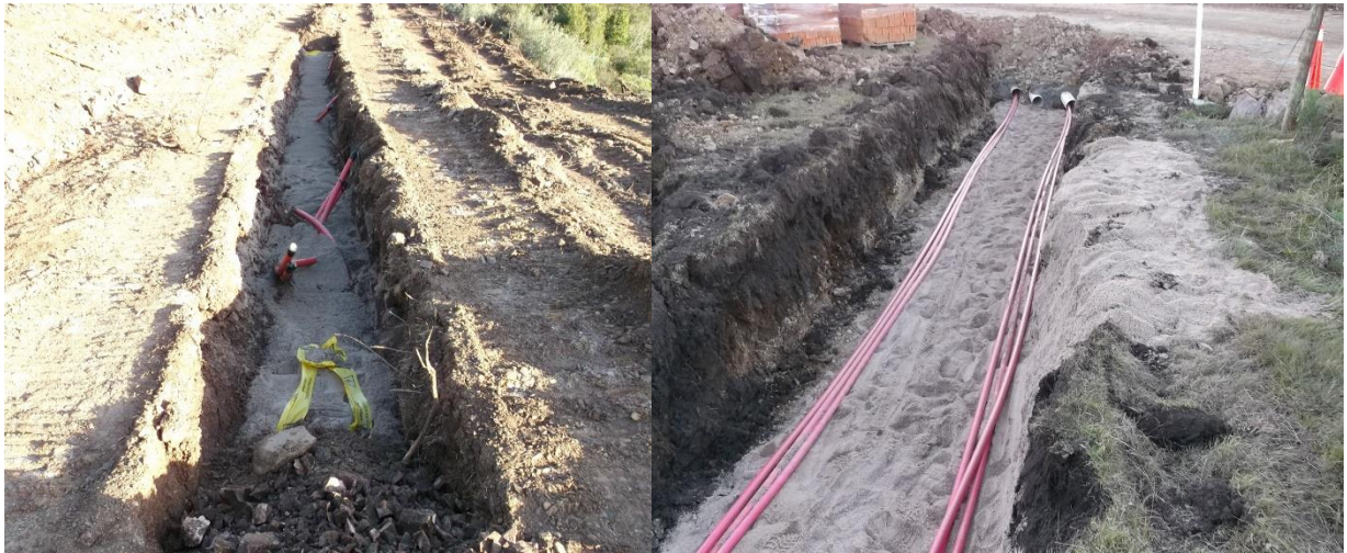
Figura 2.12. Ejemplo de canalizaciones a través de zanjas.
