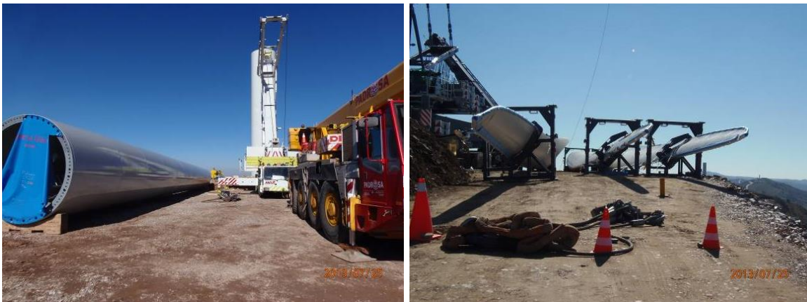
Figura 2.11. Ejemplo de las plataformas de montaje y acopio.
