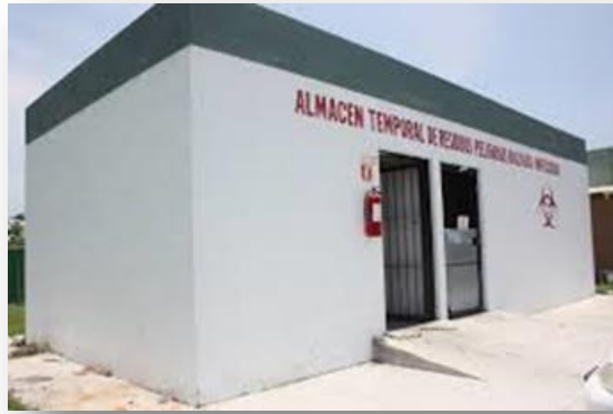
Figura VII.28. Almacén temporal de residuos peligrosos.
