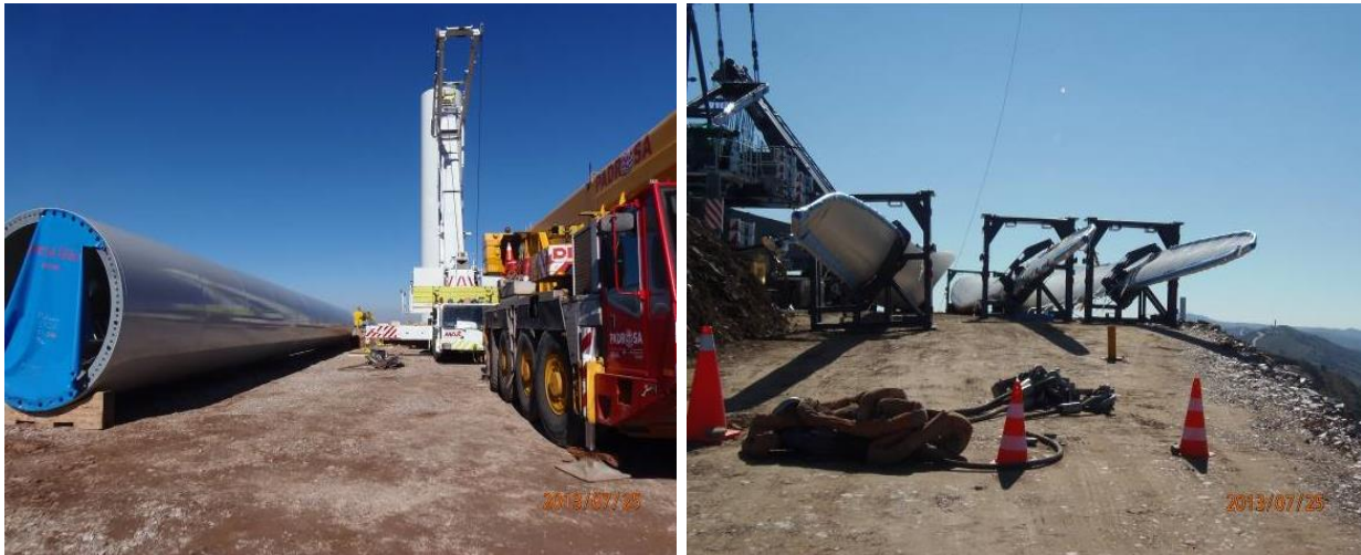
Figura 2.14. Ejemplo de las plataformas de montaje y acopio.
