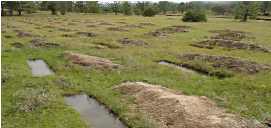
Figura 8.347. Ejemplo de Zanjas trincheras.
