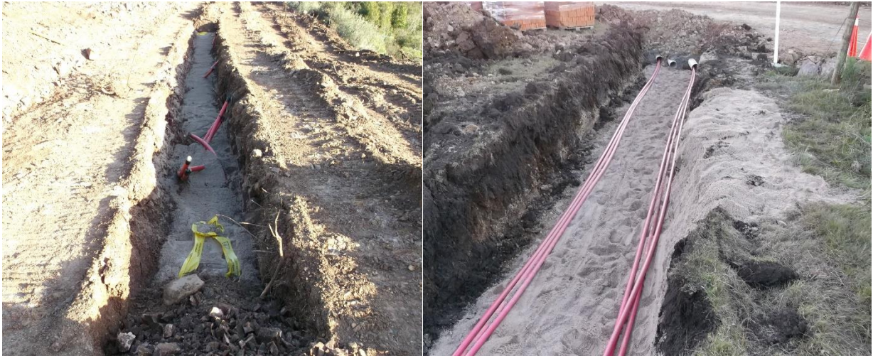
Figura 2.16. Ejemplo de canalizaciones a través de zanjas.
