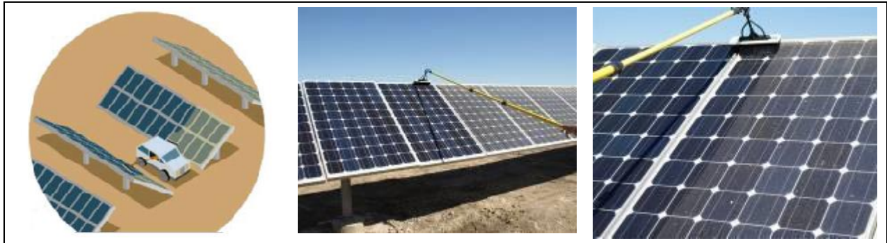
Figura II.16 Esquema de limpieza de los paneles fotovoltaicos.
