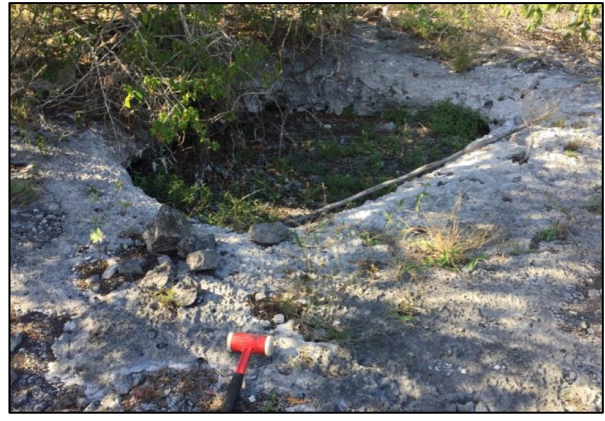
Fotografía IV.3 Vista de agujeros rellenos de material limoso.
