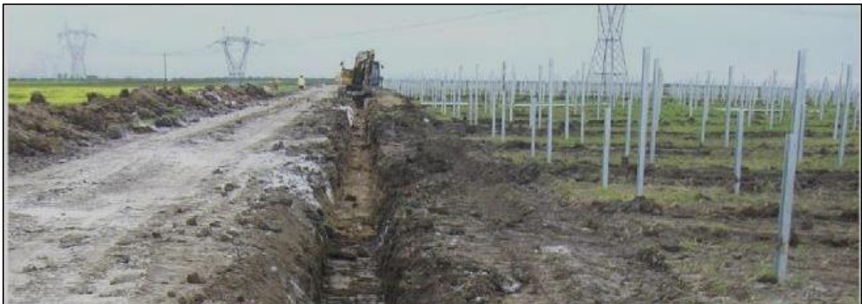
Figura II.11 Ejemplo de las vistas de las zanjas.
