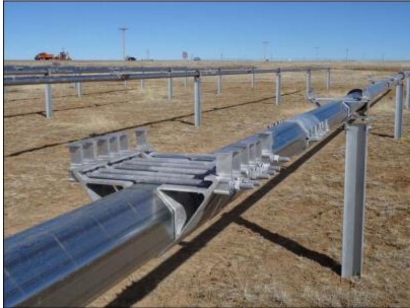
Figura 7: Imagen representativa de la instalación de los seguidores solares. Ref. "DuraTrack HZ v3 Installation Guide".
