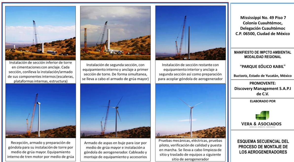
Figura II.9. Montaje de los aerogeneradores
