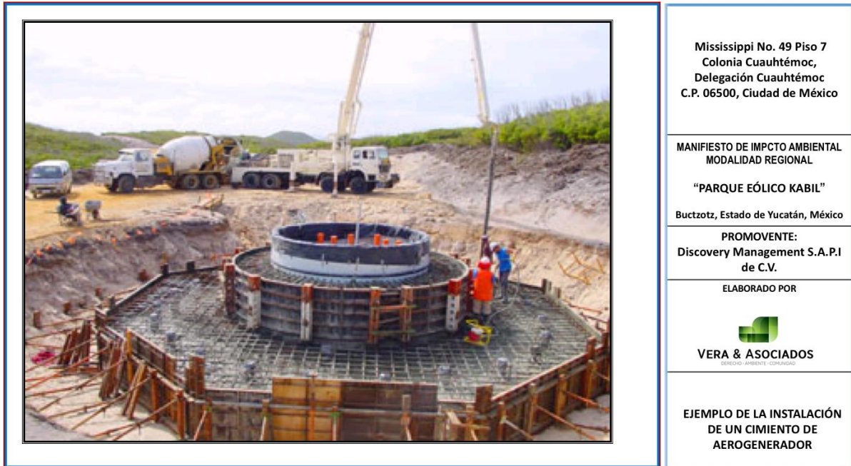
Figura II.6. Ejemplo de una cimentación de un aerogenerador
