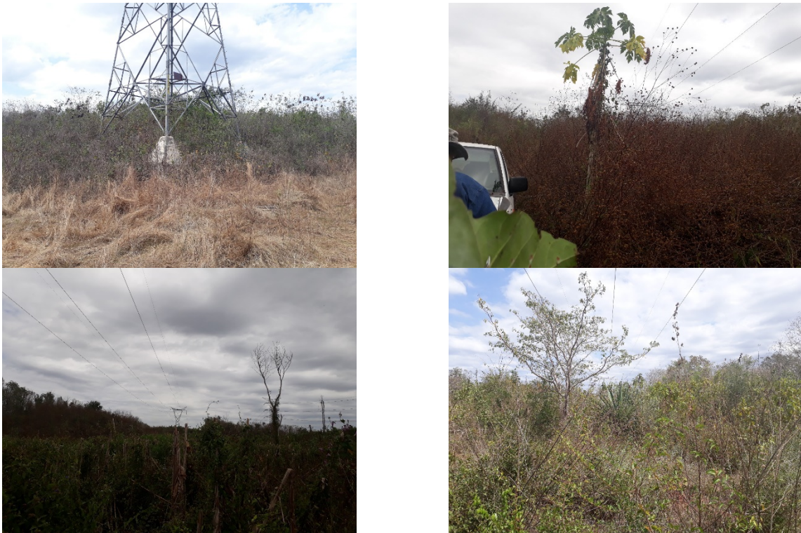
Figura 4. 13. Vista general de la vegetación encontrada en la línea de transmisión.
