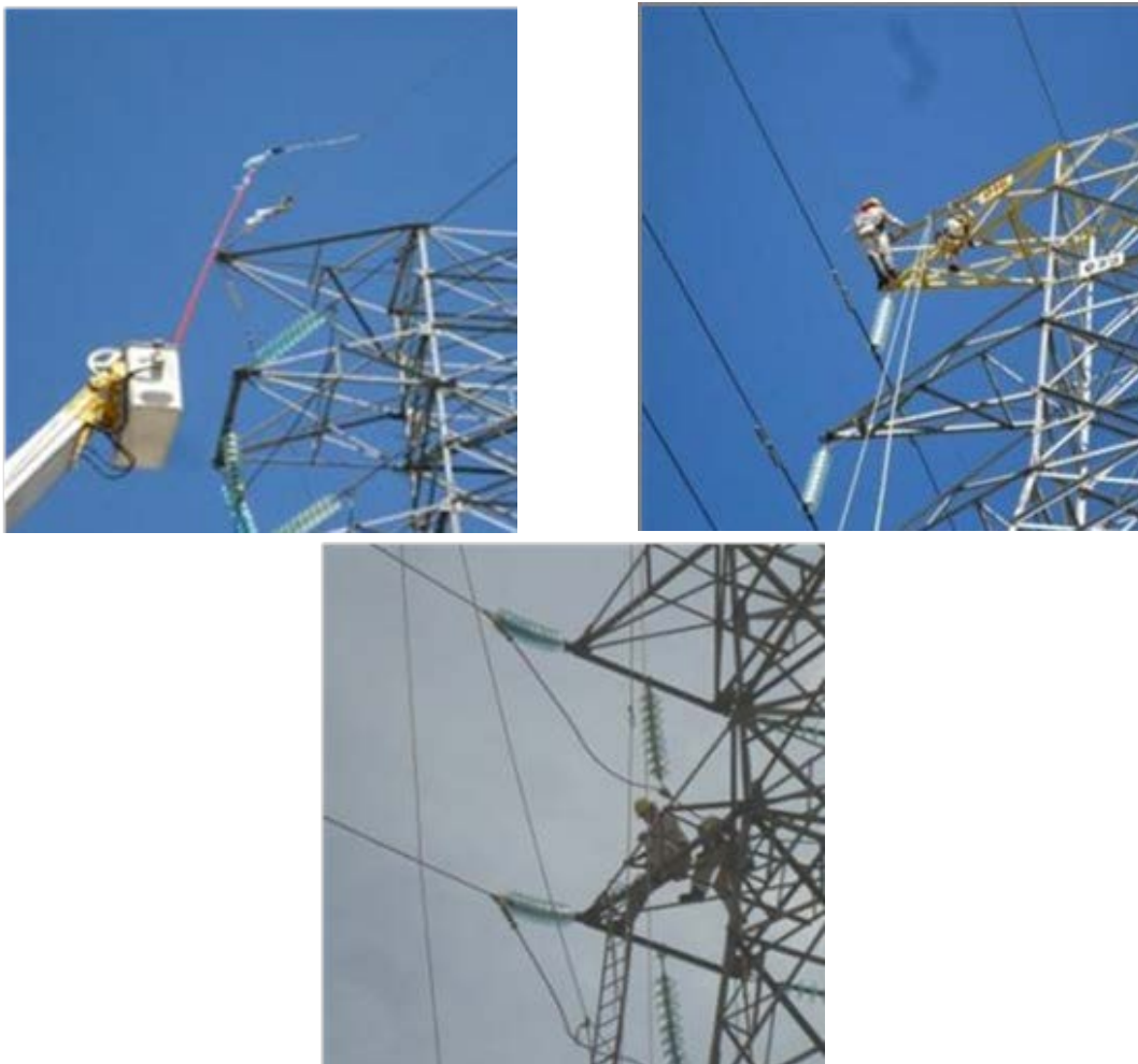
Figura 2. 11 Actividades realizadas durante el mantenimiento técnico de la línea de transmisión.
