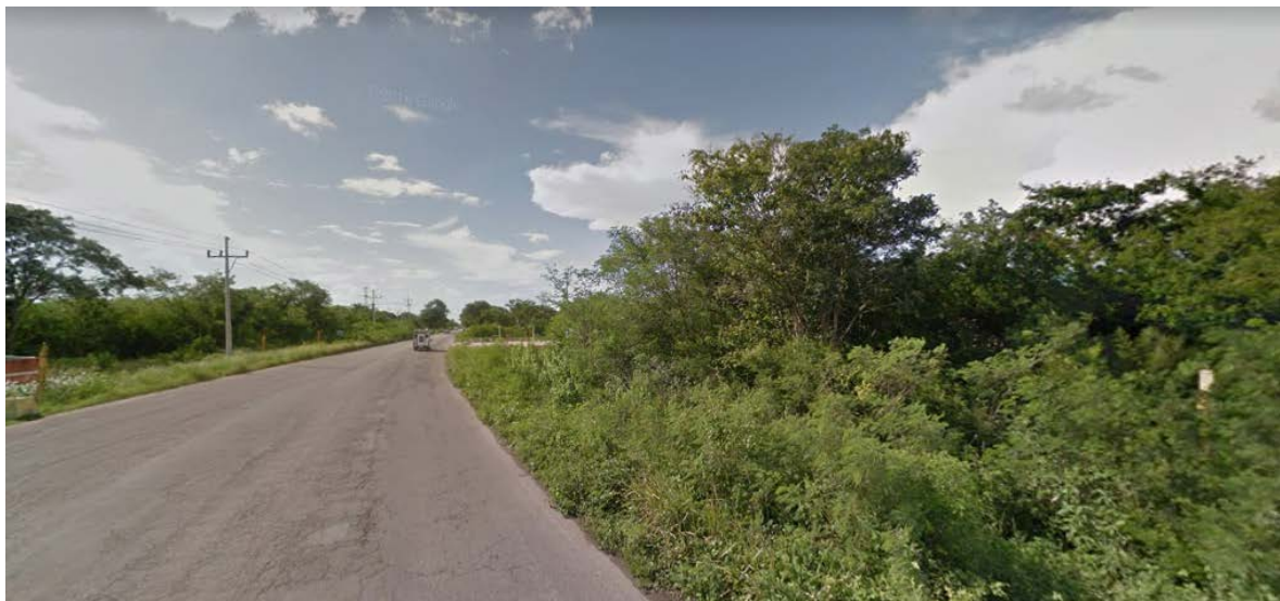
Figura 2. 9. Vista de la L.T. en el municipio de Kanasín (Calle 18).
