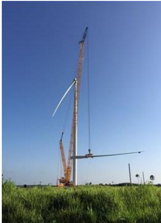
Figura II.18. Montado de buje y palas.
