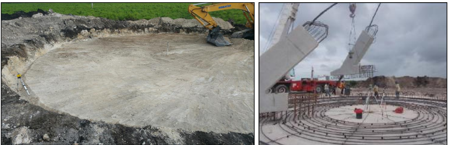
Figura II.11. Trabajos de excavación y armado de la cimentación de los aerogeneradores.
