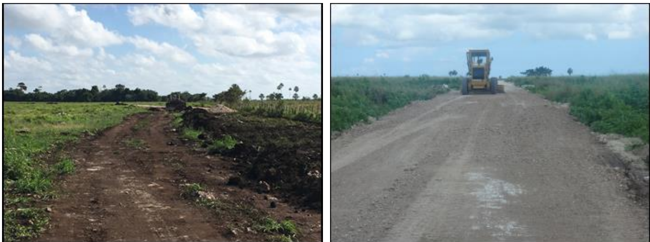
Figura II.6. Construcción de los caminos internos.
