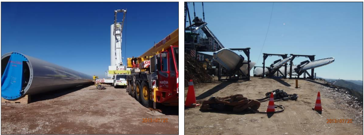
Figura II.9. Plataformas de montaje y acopio.
