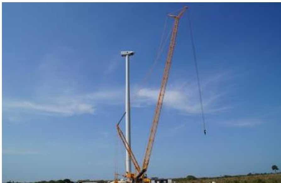
Figura II.23. Grúas a utilizar.
