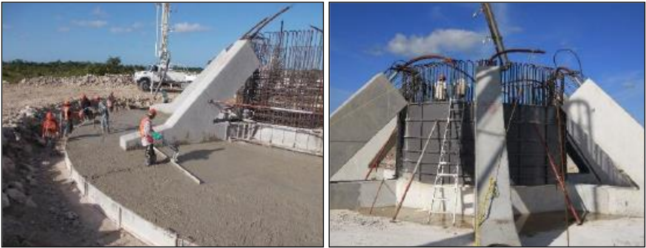
Figura II.12. Trabajos de encofrado y hormigonado del pedestal cilíndrico.
