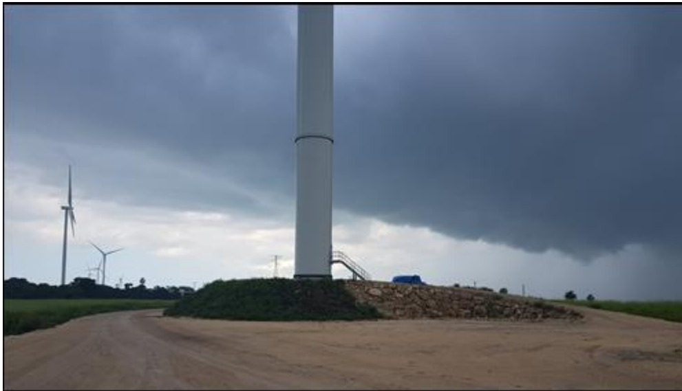
Figura II.13. Torres de los aerogeneradores.
