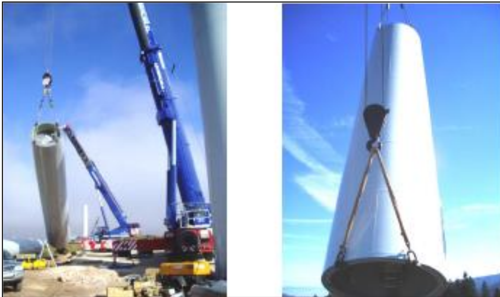
Figura II.16. Ensamble de los tramos de la torre
