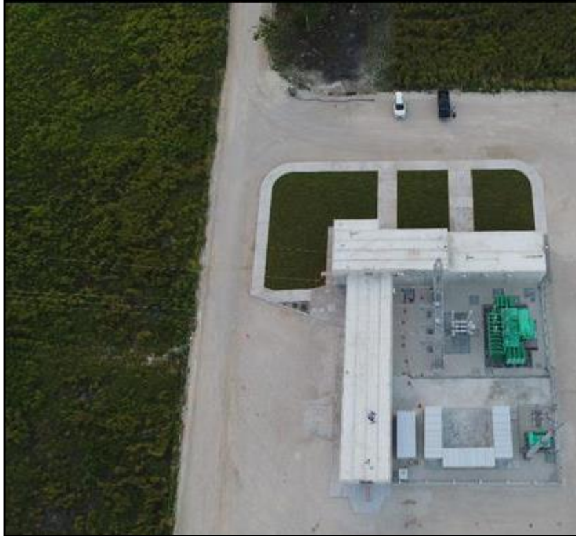
Figura II.22. Subestación del Parque Eólico Tizimín.
