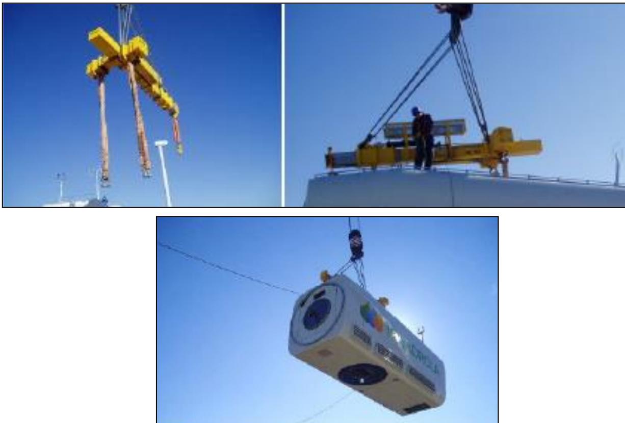
Figura II.17. Izado de la nacelle.
