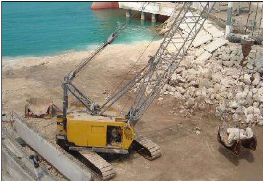
Figura II.7. Imagen ilustrativa de charola cargada con piedra para conformación de capa de coraza.
