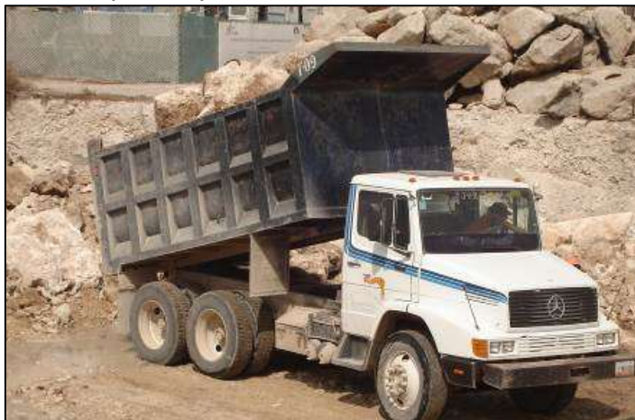
Figura II.6. Imagen ilustrativa de la conformación de capa secundaria mediante colocación de material pétreo.
