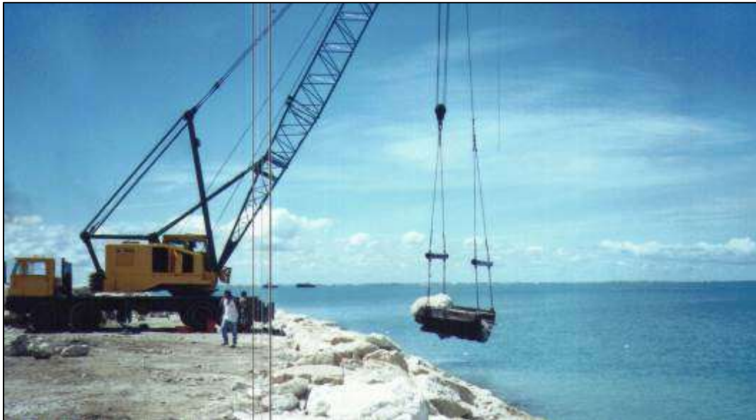
Figura II.4. Imagen ilustrativa de maniobras de charola con piedra para conformación de berma de asiento
