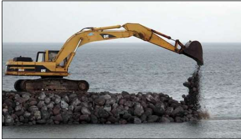
Figura II.5. Imagen ilustrativa de la conformación de capa de núcleo de plataforma, con material pétreo colocado con excavadora.
