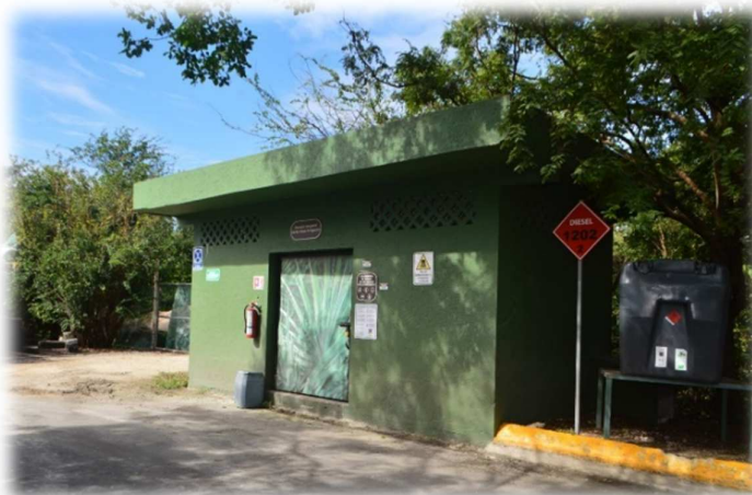
Figura VI-4 Ejemplo de almacén temporal de residuos peligrosos para el proyecto.
