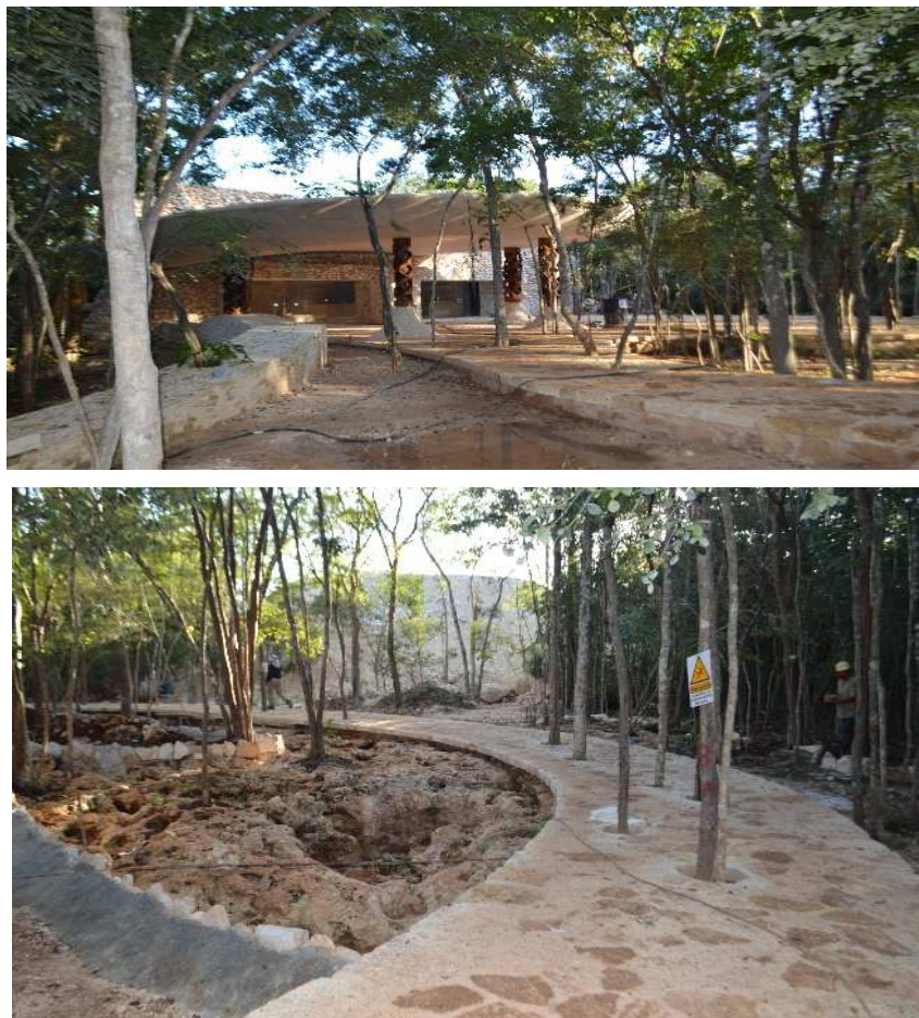
Figura II.20 Fotografía Tienda-Taquilla Zopilotes.
