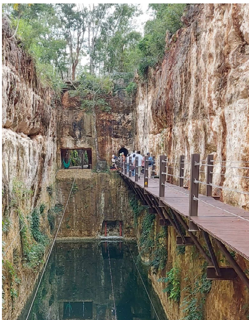
Figura II.11 Fotografía puente fijo.
