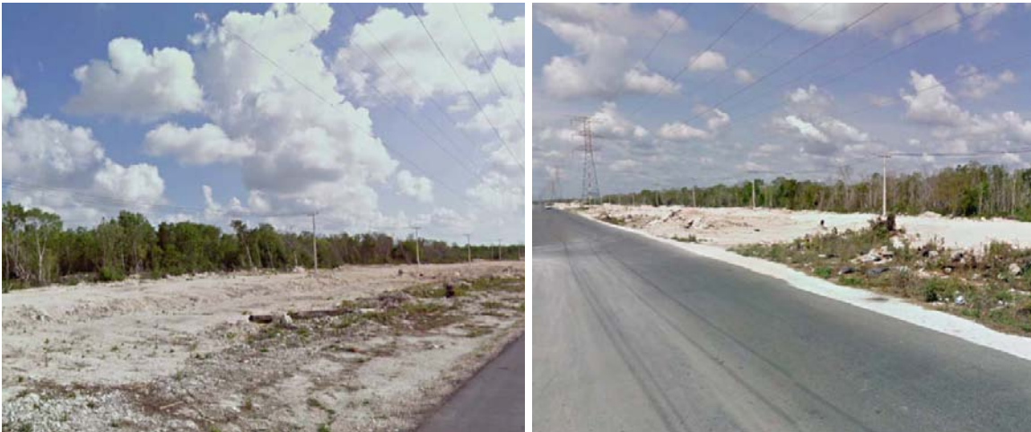
Figura 23. Construcción de la vialidad que afecta parte del predio.
