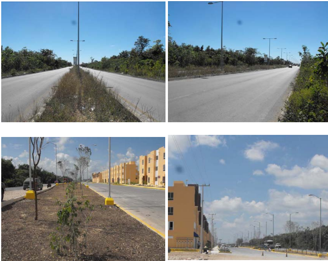
Figura 3. Vialidades que atraviesan el predio de la parcela 222, construidas por el Municipio de Benito Juárez.
