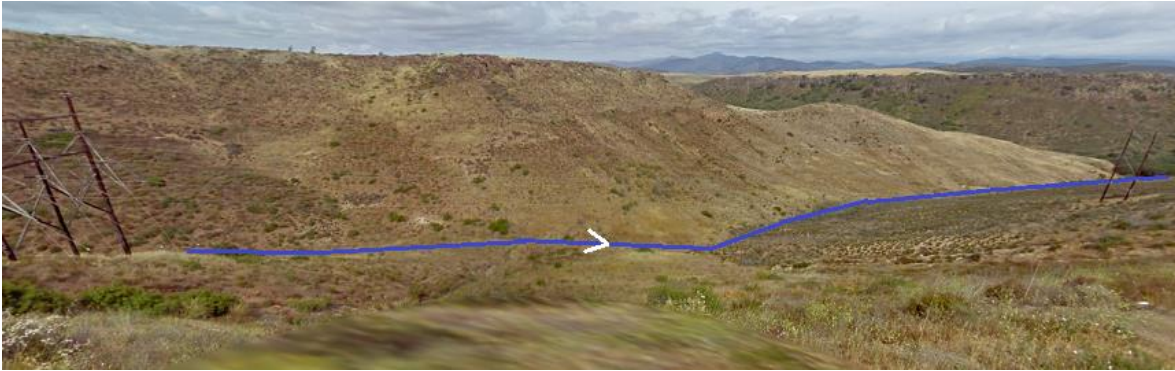
Foto 2.- Siguiente sección del gasoducto al fondo de la cañada para prevenir erosionar el suelo del sitio, donde se sigue apreciando la escasa vegetación del área, conformada por pastos y herbáceas.
