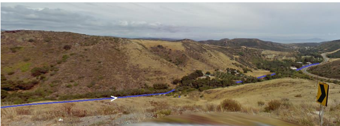
Foto 4.- última sección del trazo del gasoducto que atraviesa entre la zona de arbolado del fondo de la cañada, junto a un pequeño asentamiento humano hasta entroncarse de nuevo con la carretera libre federal No. 1. Igualmente se respetarán los árboles y arbustos.
