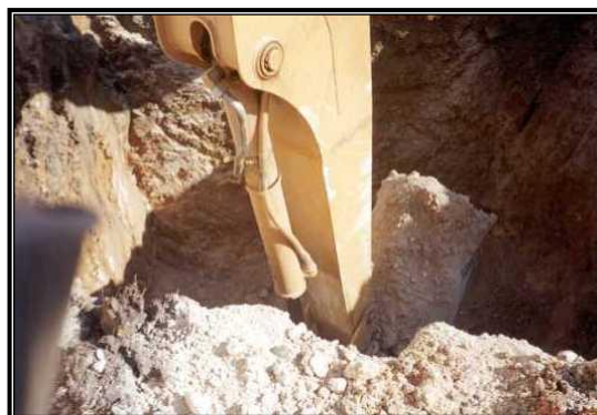
Figura II.6 Excavación de cepa con retroexcavadora
