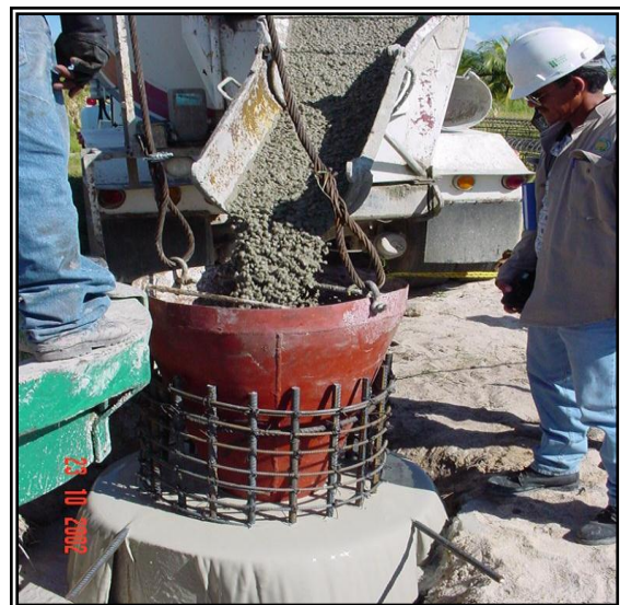
Figura II.12 Colado de pilotes.
