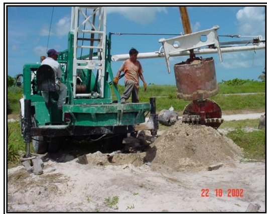
Figura II.11 Excavaciones para hincado de pilotes.
