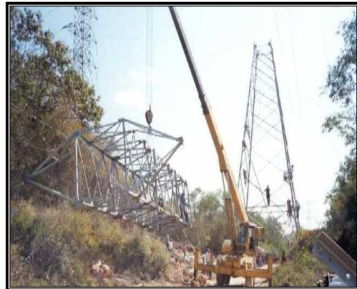
Figura II.14 Montaje de estructuras
