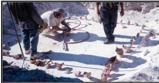
Figura II.7 Barrenaciones para anclaje en roca
