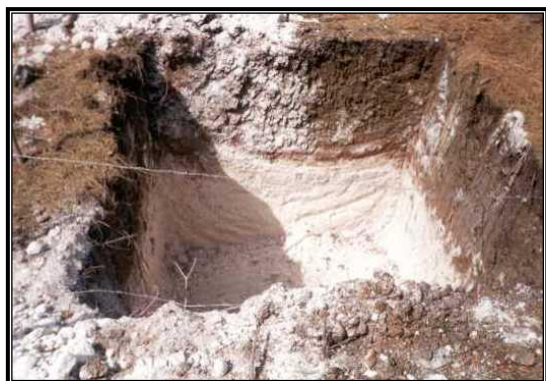
Figura II.5 Cepa para cimentación de torre estructural
