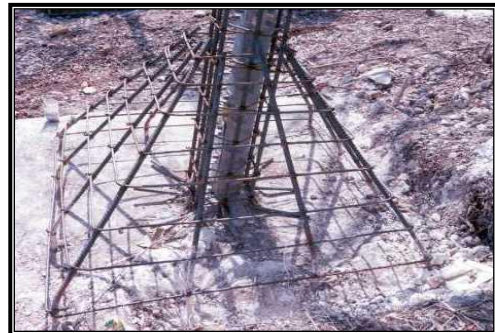
Figura II.7 Acero de refuerzo de una cimentación
