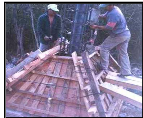
Figura II.8 Colado de cimentación en cimbras de madera
