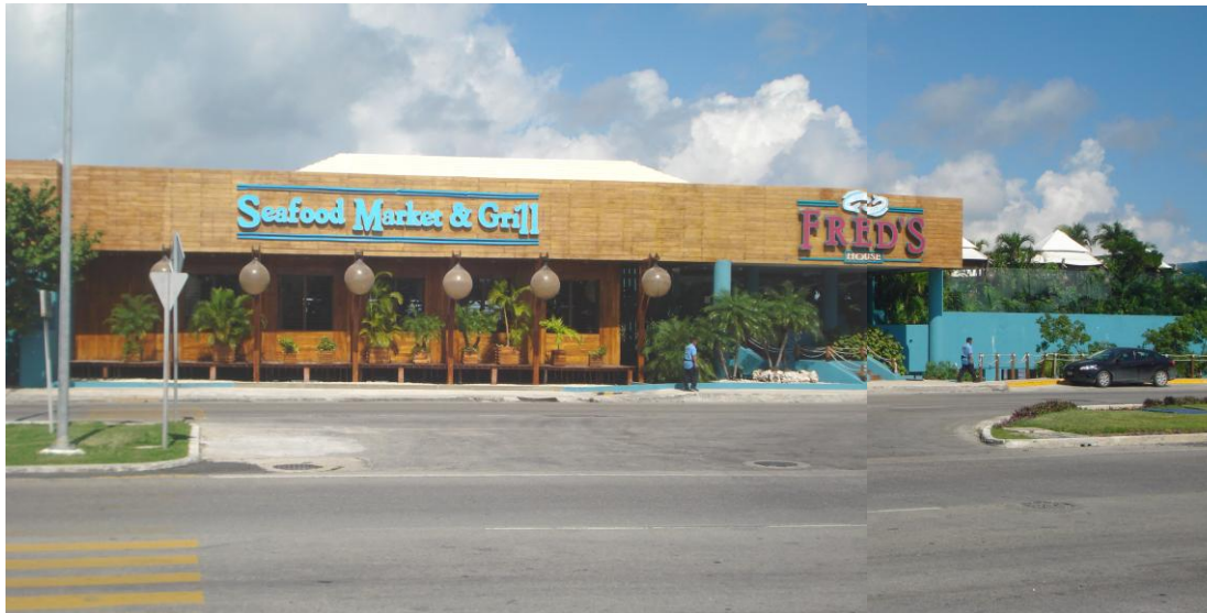
Figura 2.1 Vista de la fachada del Restaurante.
