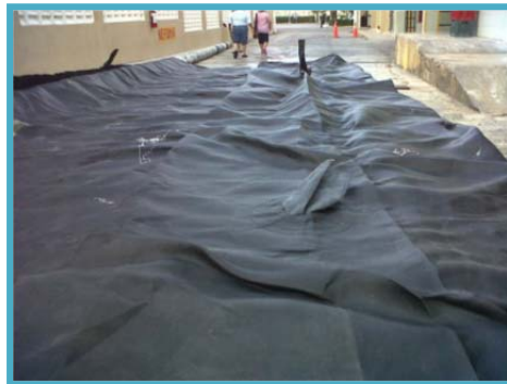
Figura II_ 5. Tubo de geotextil sin el relleno de arena de proyectos similares
