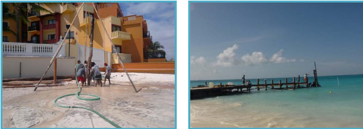
Figura II_ 9. Proceso de perforación y colocación del pilote.
