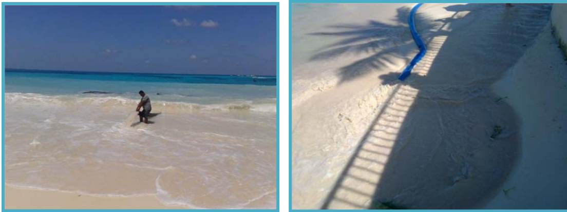
Figura II_ 14. Colocación de tuberías y mangueras para el transporte de arena
