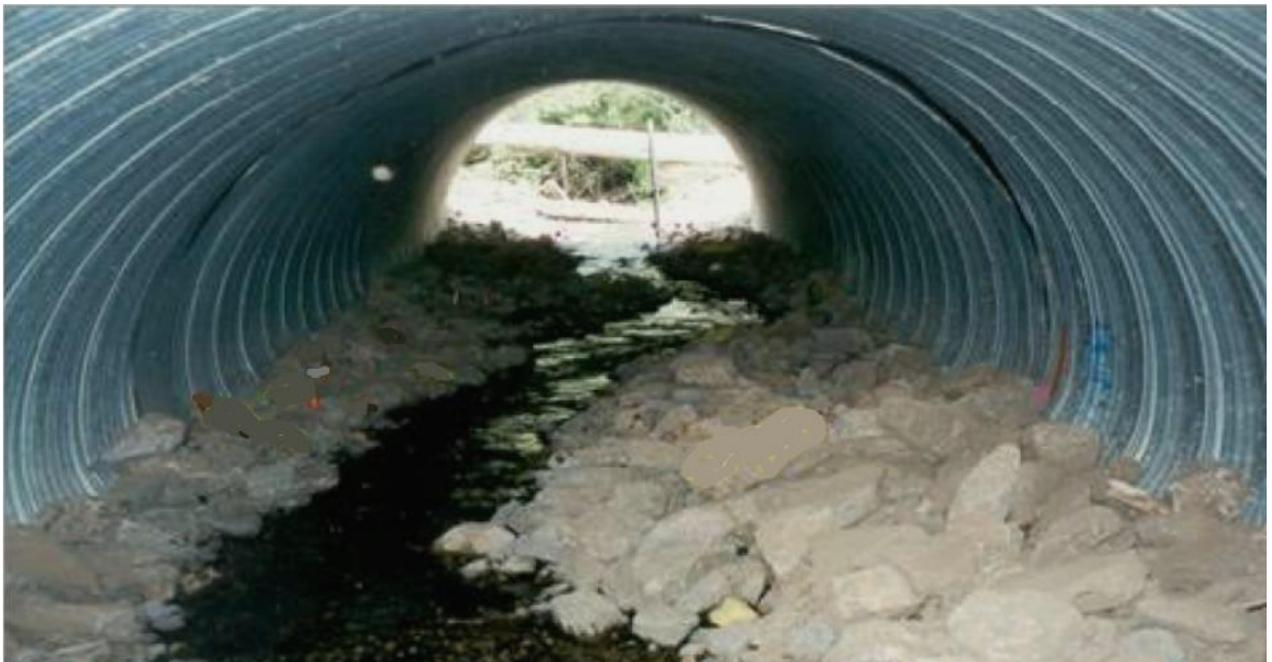
El paso de agua, para asegurar su integración ambiental debe de ser, forzosamente, más ancho que el cauce natural adyacente y deberá de tener un lecho natural estable en su interior a efecto de mantener la conectividad del escurrimiento que protege y evitar la aceleración del flujo y la consecuente erosión hídrica.
