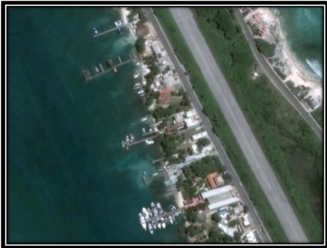
Figura 6. Atracaderos de uso particular aledaños al sitio de pretendida ubicación del muelle.
