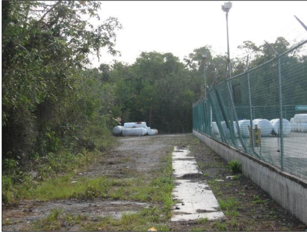
Zona de ampliación, lado norte de la Planta de Almacenamiento y Distribución de gas L.P.
