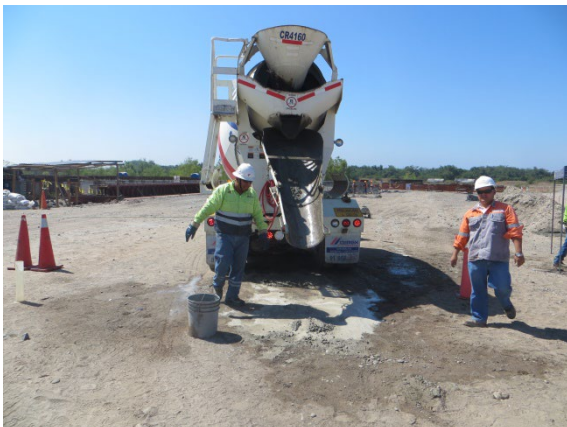
Contaminación de suelo por disposición incorrecta de residuos de mezcla y lavado de ollas.
