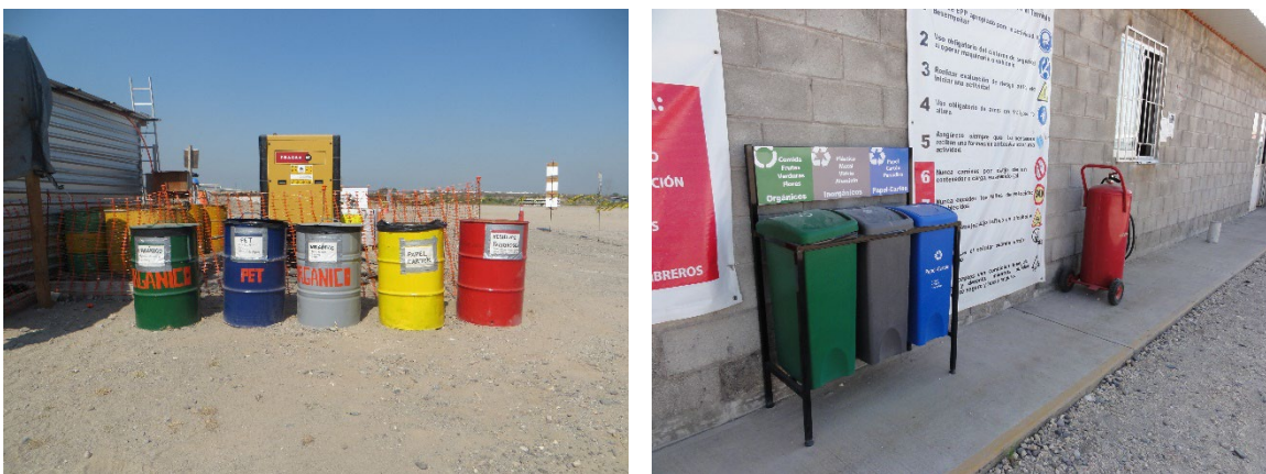
Figura II-9. Ejemplos del tipo y acondicionamiento de contenedores para residuos sólidos urbanos que se pueden usar en los frentes de trabajo para la disposición separada de los residuos.
