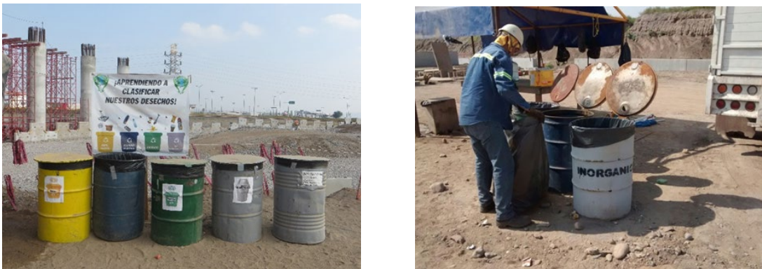
Figura II-7. Ejemplo del acondicionamiento y diferenciación y colecta de residuos sólidos urbanos y de manejo especial en proyectos en construcción.
